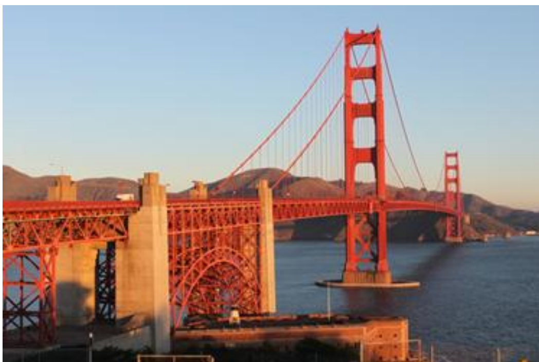
Εικόνα 3.3: Η Γέφυρα Golden Gate στο San Francisco ( goldengatebrige.org )
