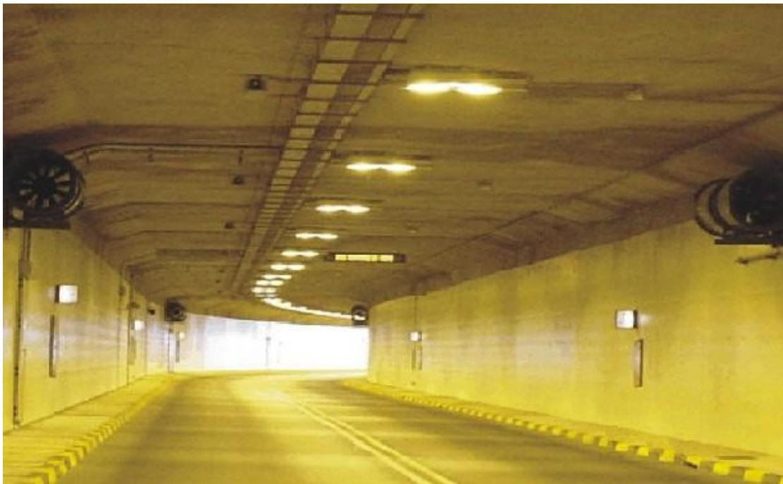
Εικόνα 6.16: Φωτογραφία από το εσωτερικό της επιτυθμένης σήραγγας Ακτίου - Πρεβέζης ( greek-motorways.net )
