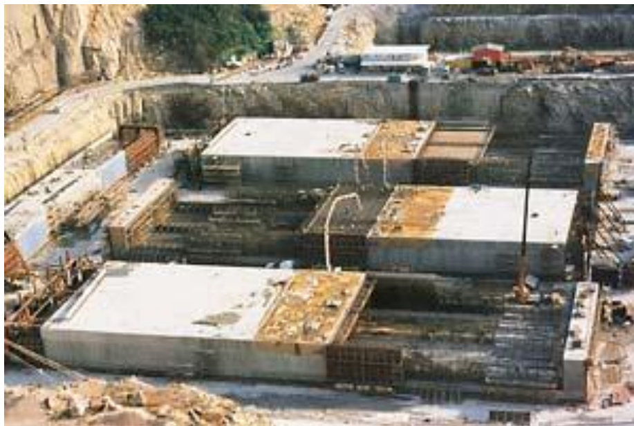
Εικόνα 6.15: Κατασκευή σπονδύλων ( www.cityu.edu.hk )
