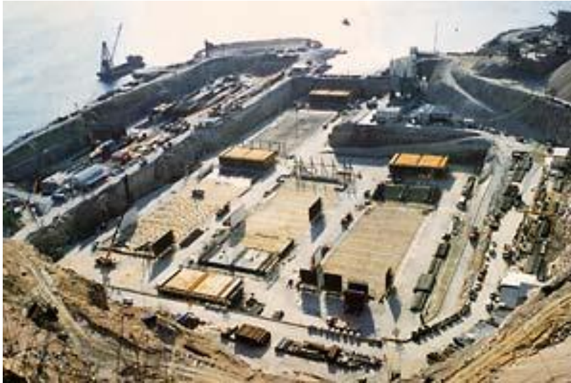
Εικόνα 6.13: Λεκάνη κατασκευής στοιχείων επιτυθμένης σήραγγας ( www.cityu.edu.hk )
