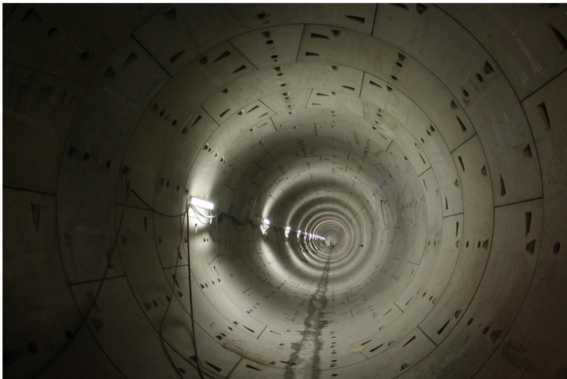
Εικόνα 2.9: Τελική επένδυση σε σήραγγα που κατασκευάστηκε από TBM (Prague Metro 2013).
