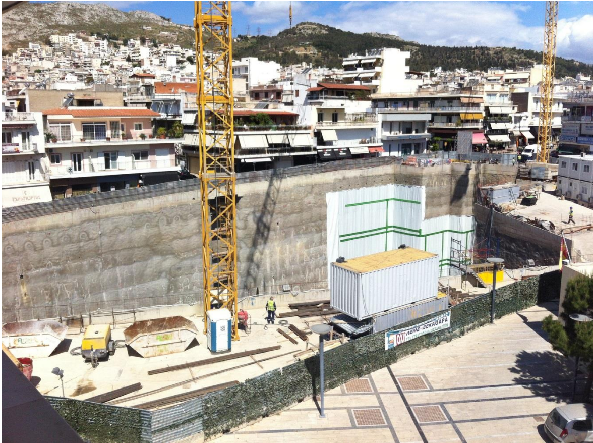
Εικόνα 2.5-1: Σταθμός Μετρό «Αγία Βαρβάρα»
