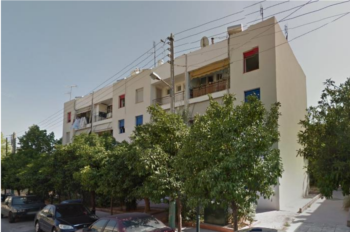
Εικόνα 2.5-3: Αποψη εργατικής πολυκατοικίας μετά την ανάπλαση
