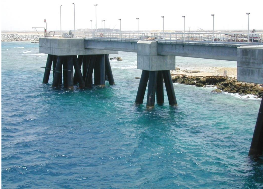
Εικόνα 1.6: Εμπηγνυόμενοι πάσσαλοι (μικρής εκτοπίσεως- ανοικτοί σωλήνες)
