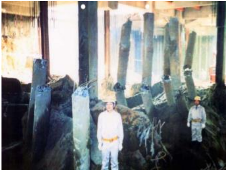
Εικόνα 1.8: Αστοχία πασσάλων ( L = 10 \text{ m} , d = 0.3 \text{ m} ) σε κινηματική επιπόνηση στον σεισμό της Niigata (1964)
