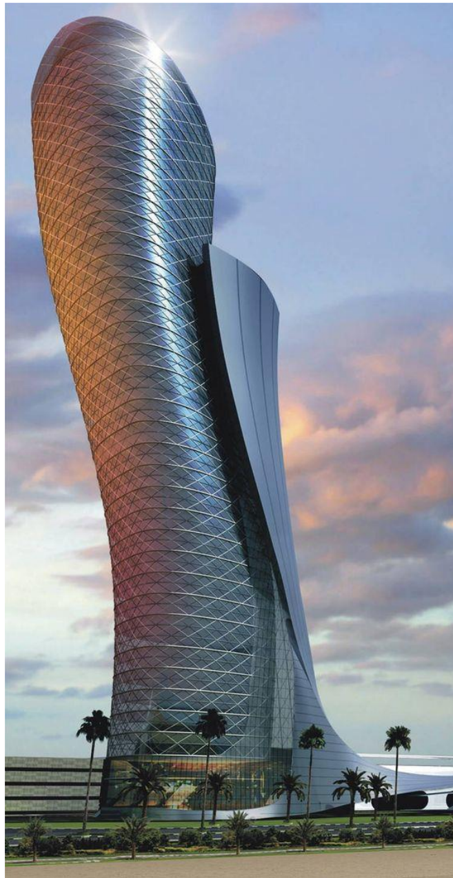
Σχήμα 1.8. Ουρανοξύστης Capital Gate στο Abu Dhabi, 2011
