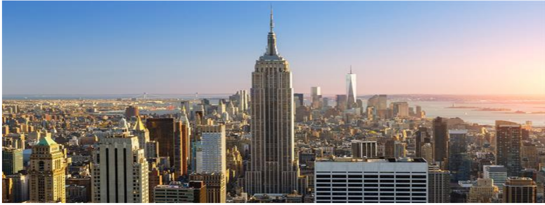
Σχήμα 1.7. Το Empire state building στη Νέα Υόρκη, 1931
