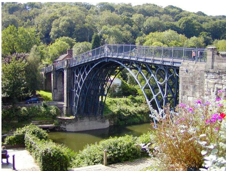
Σχήμα 1.1. Η πρώτη γέφυρα από χυτοσίδηρο Coalbrookdale, Αγγλία 1777
