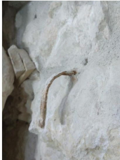
Εικόνα 19. Αγκύρια Κομνηνού για συγκράτηση λίθων MIZZY Πηγή: Προσωπικό αρχείο
