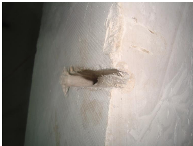
Εικόνα 52. Το λούκι αγκύρωσης με άντυγα 4,5 cm
