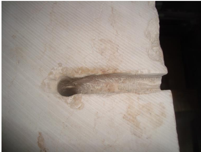
Εικόνα 51. Η οπή αγκύρωσης με άντυγα 4,5 cm, βάθος 10cm Πηγή: Προσωπικό αρχείο
