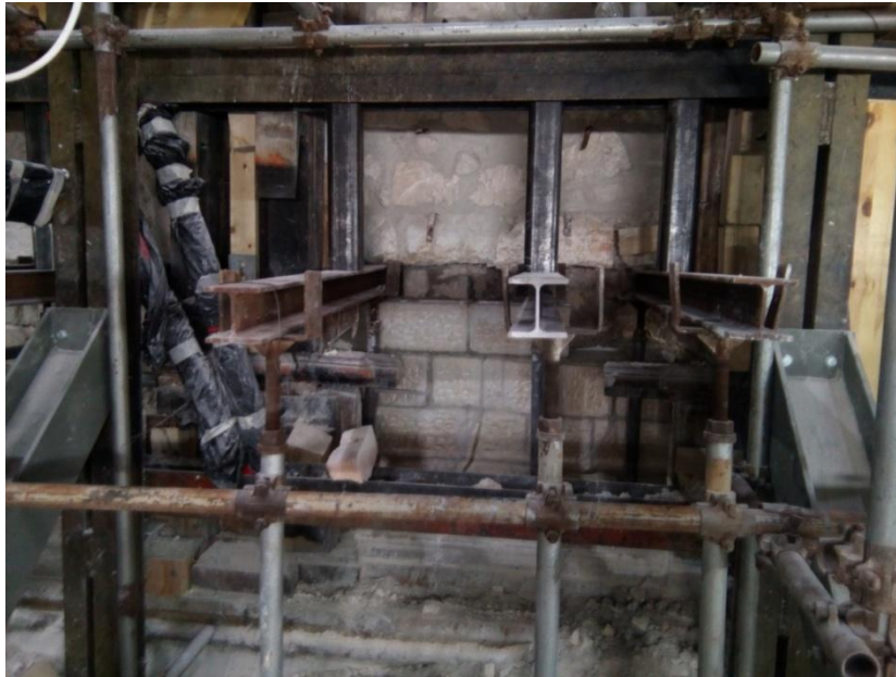
Εικόνα 25. Στην εικόνα αυτή παρατηρούμε την αντικατάσταση της τοιχοποιίας με νέους λαξευτούς λίθους στο κατώτερο και πιο ταλαιπωρημένο από την ανερχόμενη υγρασία τμήμα της. Είναι εμφανής η αρμολόγηση που έχει προηγηθεί στο υπόλοιπο τμήμα
