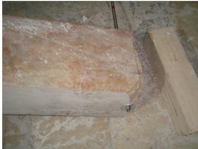
Εικόνα 41. Πλάγια όψη του θραυσμένου μαρμάρου Πηγή: Προσωπικό αρχείο
