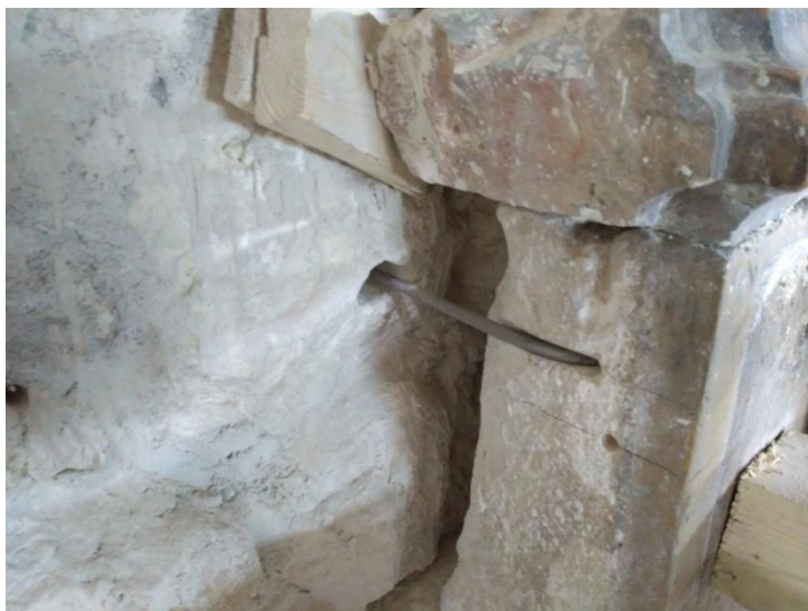
Εικόνα 28 .Οπές στις κατώτερες πλάκες της ορθομαρμάρωσης και δοκιμαστική τοποθέτηση αγκυρίου Πηγή: Προσωπικό αρχείο
