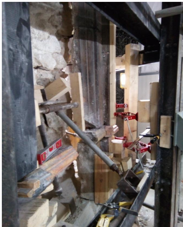
Εικόνα 23. . Διακρίνονται με κόκκινο οι χειροκίνητοι γρύλλοι για την επανάταξη των πεσσών
