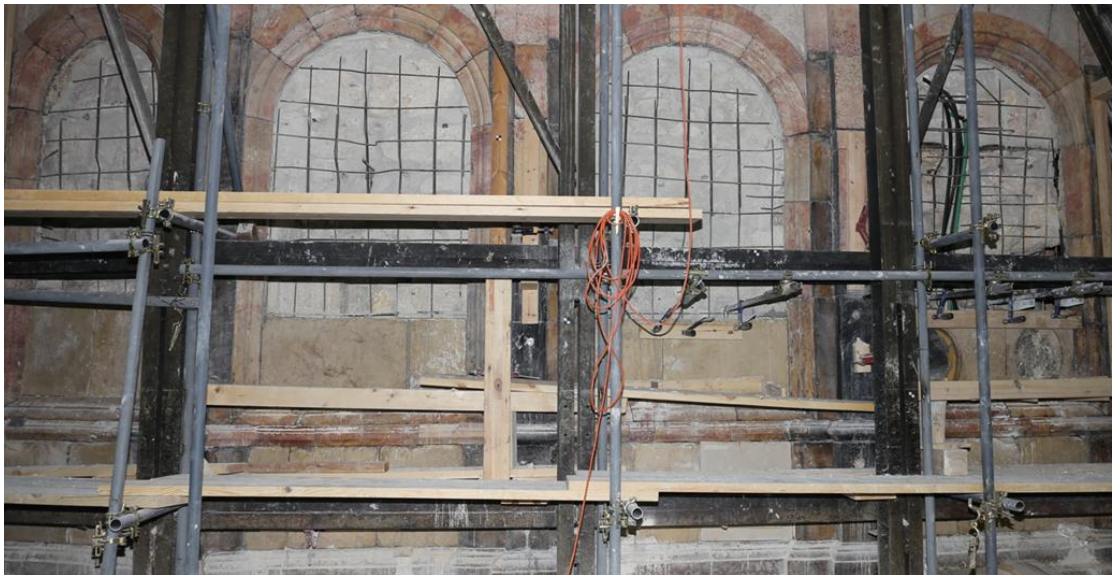
Εικόνα 32. Στιγμιότυπο κατά την επανατοποθέτηση της εξωτερικής ορθομαρμάρωσης Πηγή: Ερευνητική ομάδα ΕΜΠ
