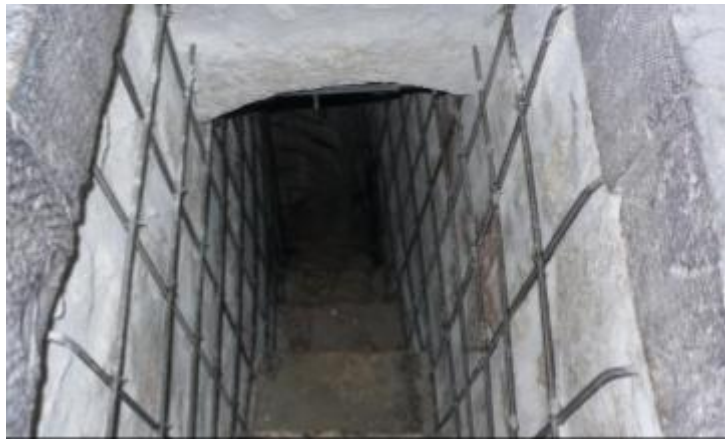
Εικόνα 27. Το νότιο κλιμακοστάσιο μετά την τοποθέτηση του πλέγματος τιτανίου
