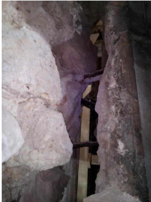
Εικόνα 18. Αγκύρια Κομνηνού για συγκράτηση λίθων SLAYEB Πηγή: Προσωπικό αρχείο
