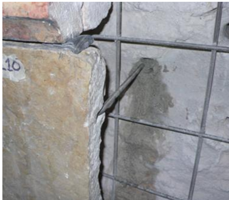
Εικόνα 68. Αγκύριο τύπου «Γ» Πηγή: Ερευνητική ομάδα ΕΜΠ, 2017
