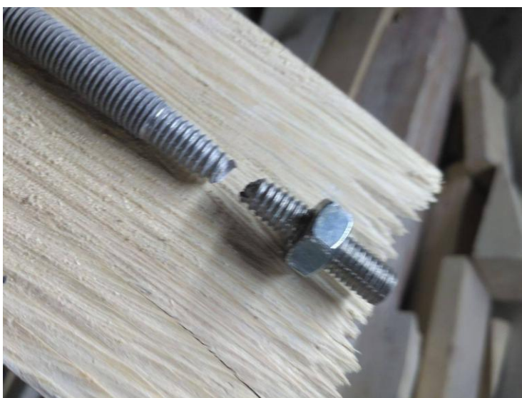
Εικόνα 61 . Διαρροή της ράβδου τιτανίου στο άνω σπείρωμα
