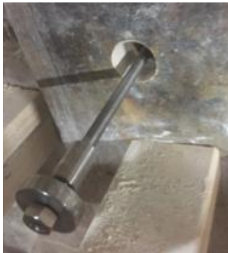
Εικόνα 66. Ευθύγραμμο αγκύριο κολώνας λίγο πριν την τοποθέτηση Πηγή: Ερευνητική ομάδα ΕΜΠ, 2017
