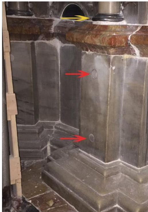
Εικόνα 30. Με κίτρινο χρώμα σημειώνονται τα αγκύρια τύπου U που συγκρατούν τα κολονάκια στην εσωτερικής ορθομαρμάρωσης στην τοιχοποιία. Με κόκκινο σημειώνονται οι θέσεις των ευθύγραμμων αγκυρίων. Διακρίνονται τάπες των οπών από το ίδιο μάρμαρο
