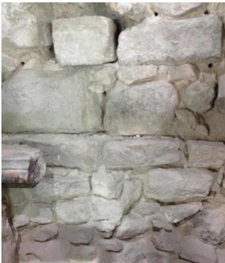
Εικόνα.17. Παρατήρηση της χρήσης μικρών και ακανόνιστων λιθοσωμάτων στα χαμηλότερα ύψη της τοιχοποιίας.
