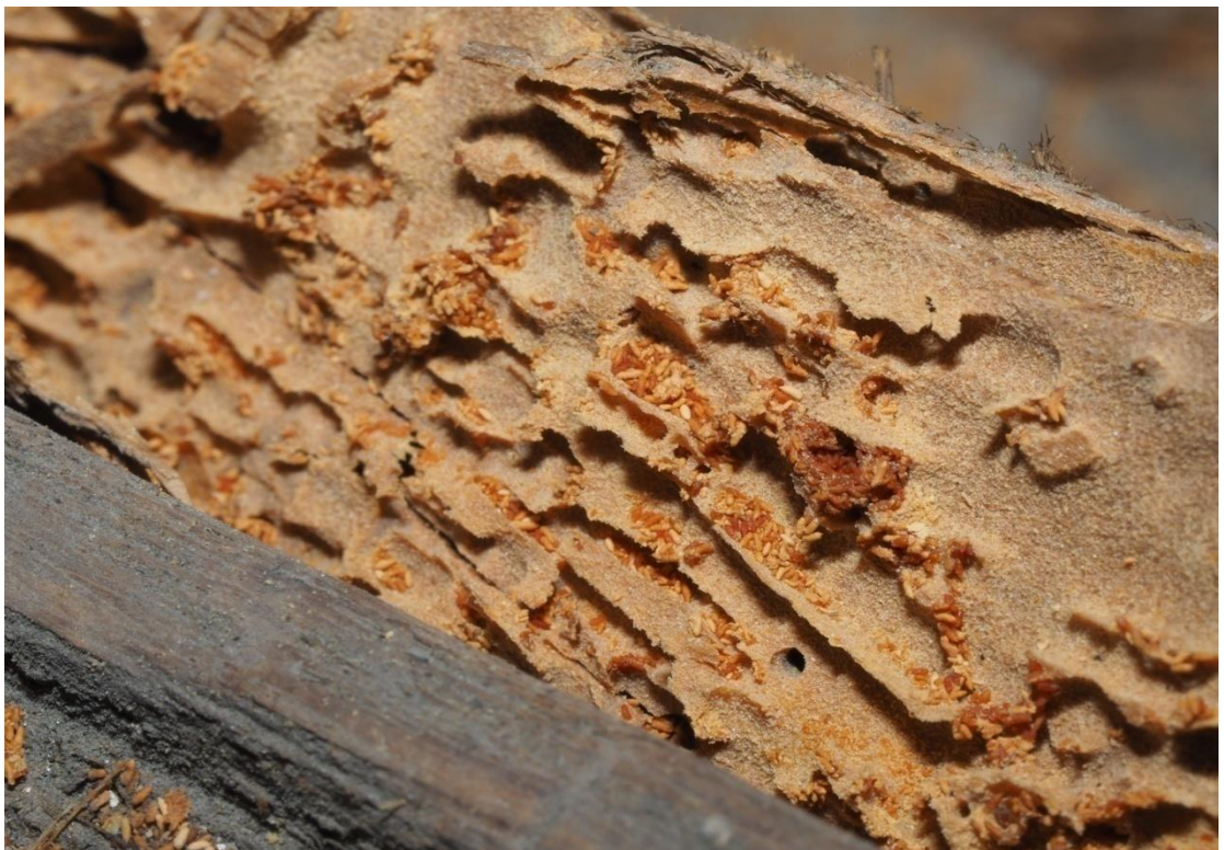
Εικόνα 6.12: Περιττώματα ξυλοφάγων εντόμων. Τα ερυθρά φανερώνουν κατανάλωση μυκήτων.
