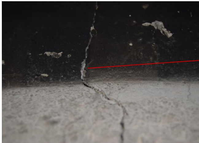
Εικόνα 3.18: Επιφανειακές ρηγματώσεις μέσου μήκους 4,416 mm.
