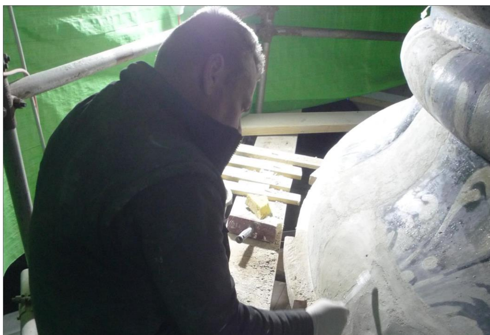
Εικόνα 6.30: Κατά την διαδικασία εφαρμογής των στρώσεων του υλικού Master Emaco S TIX 285.
