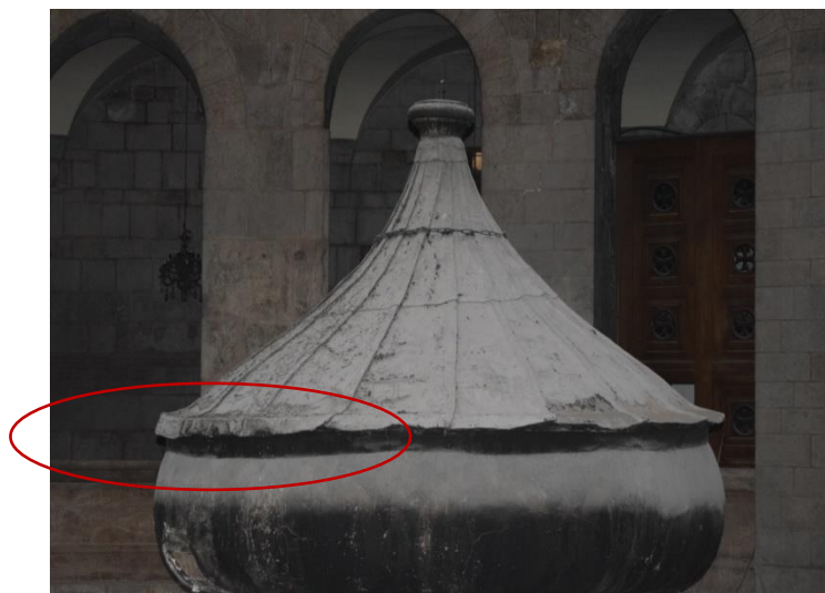
Εικόνα 3.15: Κλίση στο φύλλο μολύβδου.
