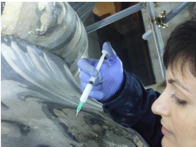
Εικόνα 6.28: Κατά τη διαδικασία στερέωσης του σοβά με το υλικό Primal 3% acrylic emulsion.
