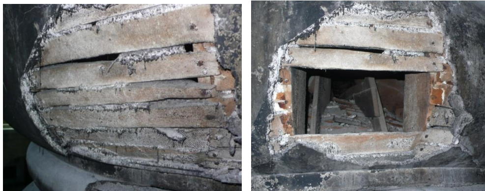
Εικόνα 3.7: (Δεξιά) Οπή από την οποία παρατηρήθηκε η δομή του Τρούλου εσωτερικά για να αποτιμηθεί ο τρόπος κατασκευής του. (Αριστερά) Μπαγδατί που αφαιρέθηκαν για να αποκαλυφθεί η δομή του Τρούλου εσωτερικά.
