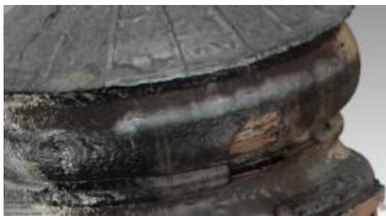
Εικόνα 2.12: Τμήμα του τρούλου που έχει μερικώς καταστραφεί.
