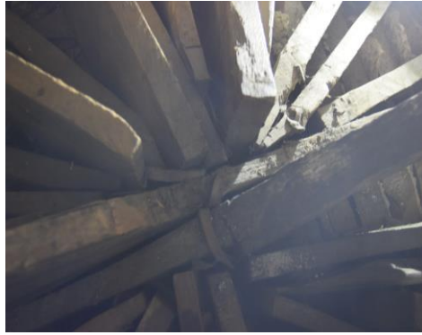
Εικόνα 3.12: Λεπτομέρεια σύνδεσης ακτινών του εσωτερικού θόλου.
