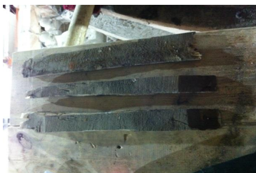
Εικόνα 3.8: Μπαγδατί που αφαιρέθηκαν για να αποκαλυφθεί η δομή του Τρούλου εσωτερικά.
