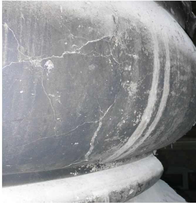
Εικόνα 3.20: Επιφανειακές ρηγματώσεις.
