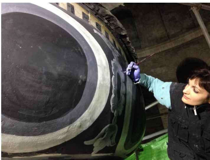
Εικόνα 6.32: Κατά την διαδικασία εφαρμογής των χρωμάτων.
