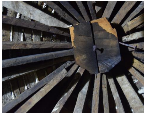
Εικόνα 3.13: Λεπτομέρεια σύνδεσης ακτινών του εξωτερικού θόλου.
