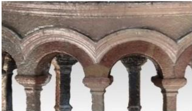
Εικόνα 2.11: Λεπτομέρειες κίωνων τρούλου. Από την εικόνα αυτή είναι εμφανής ο εντοπισμός και ο διαχωρισμός των διαφορετικών λίθων που χρησιμοποιήθηκαν για την κατασκευή του τρούλου.
