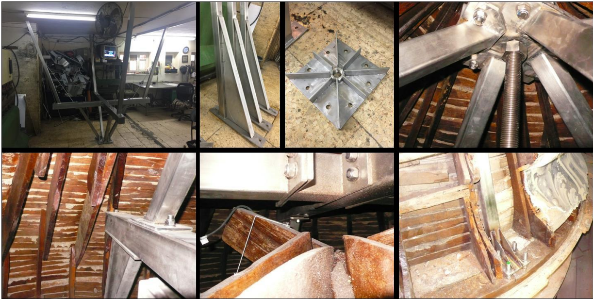
Εικόνα 5.17: Συναρμολόγηση και τοποθέτηση της μεταλλικής κατασκευής στον Τρούλο.
