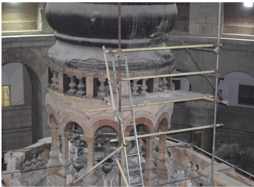
Εικόνα 3.2: Άποψη ξύλινου κριώματος (1ο στάδιο) με μεταλλικά στηρίγματα στην ανωδομή του Ιερού Κουβουκλίου.
