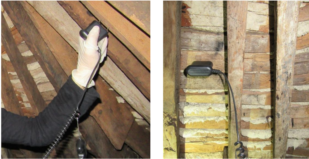
Εικόνες 3.28-3.29: Μέτρηση της υγρασίας των ξύλων των θόλων του Τρούλου με τον μετρητή υγρασίας METRICA 60274.
