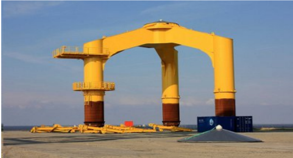
Εικόνα 2.11 : Κατασκευή στήριξης τριπλού πυλώνα [39]
