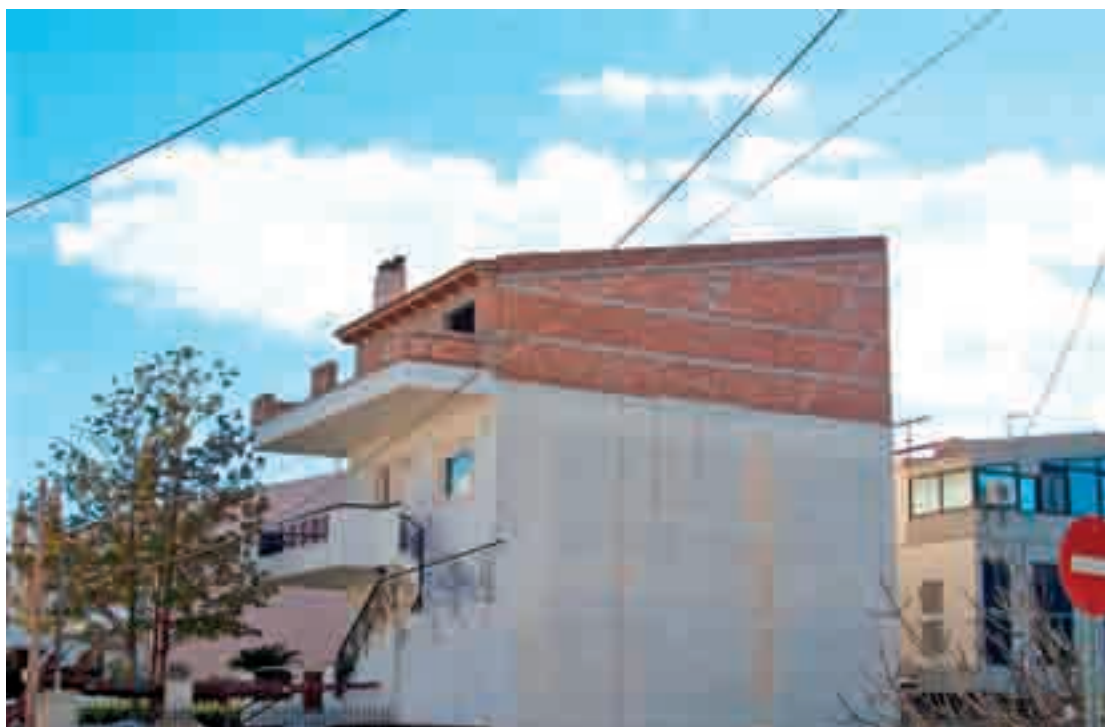
Σοφίτα υπό κατασκευή
