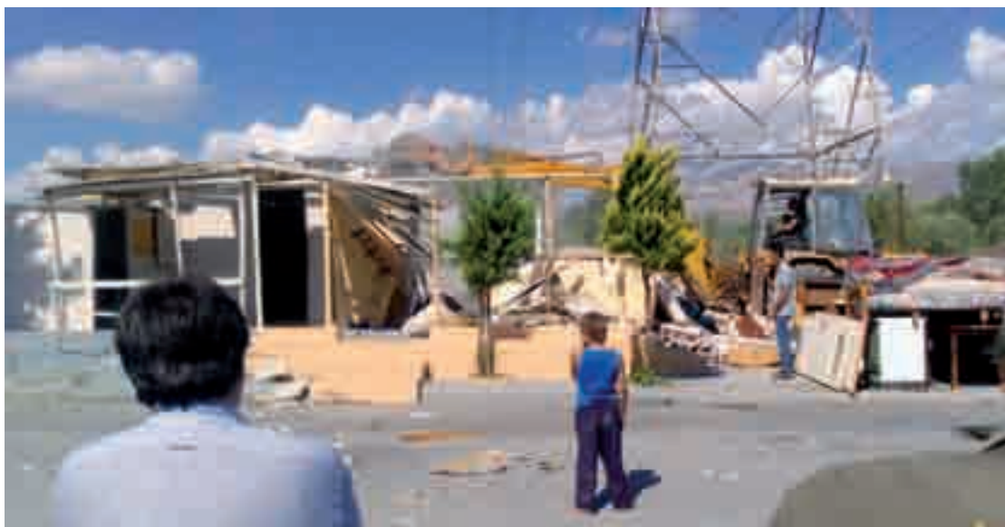
Η ώρα της κατεδάφισης
