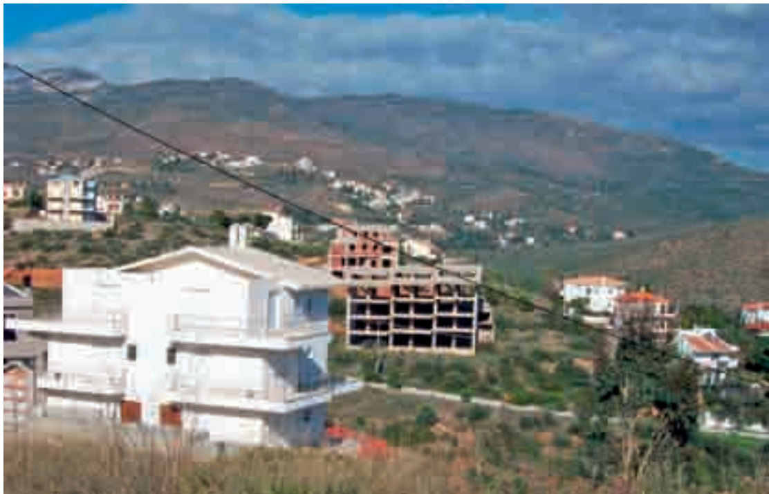
Σκελετός οπλισμένου σκυροδέματος, όπως φαίνεται από την πλευρά της κατωφέρειας
