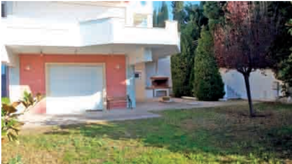
Χαρακτηριστική περίπτωση υπογείου ξεμπαζωμένου στη μια πλευρά
