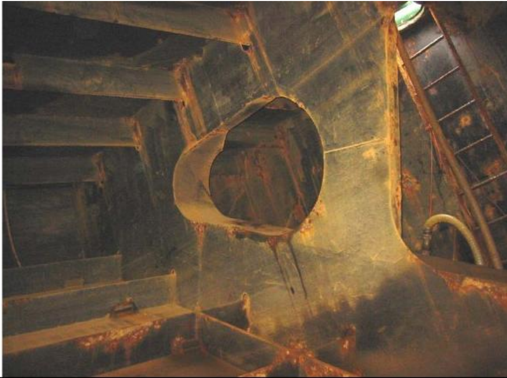
Εικόνα 2.24 - Άνω πλευρική δεξαμενή έρματος
