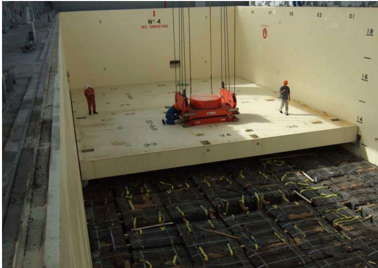
Εικόνα 2.7 - Τοποθέτηση μεταλλικών αποσπώμενων καλυμμάτων για τη δημιουργία διπλού καταστρώματος
