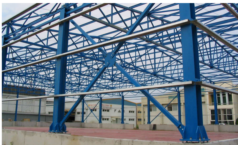
Εικόνα 1-1: Πρακτικό παράδειγμα κεντρικών συνδέσμων δυσκαμψίας
