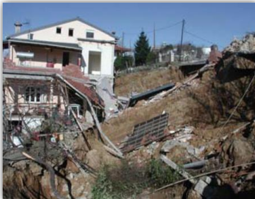
Εικόνα 4.4. Κατολίσθηση στο Χαροκόπι Ιωαννίνων, (Δεκέμβριος 2005)
