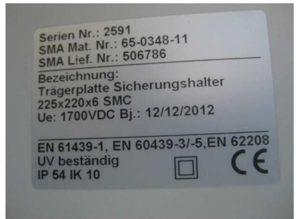
Φωτογραφία. 6: Πινακίδα στοιχείων DC υποπίνακα
