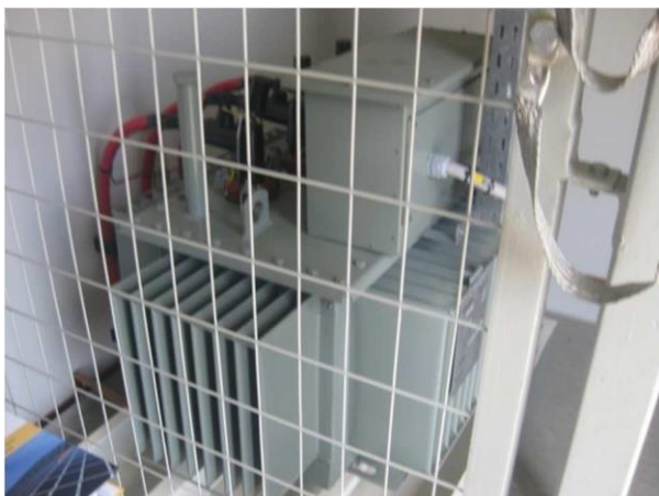
Φωτογραφία. 9: Μετασχηματιστής ιδιοκαταναλώσεων
