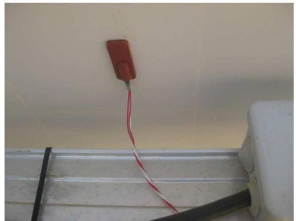
Φωτογραφία. 14: Αισθητήρας θερμοκρασίας Φ/Β πάνελ
