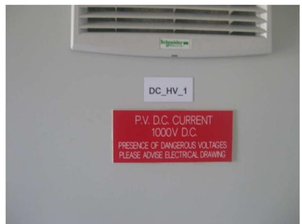
Φωτογραφία. 6: Πινακίδα στοιχείων DC υποπίνακα
