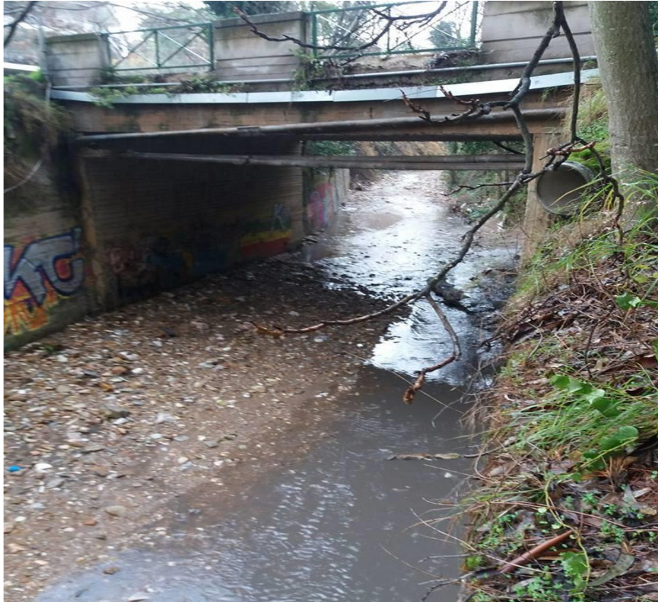
Εικόνα 3.8: Η γέφυρα στην οδό Δαφνίδος
