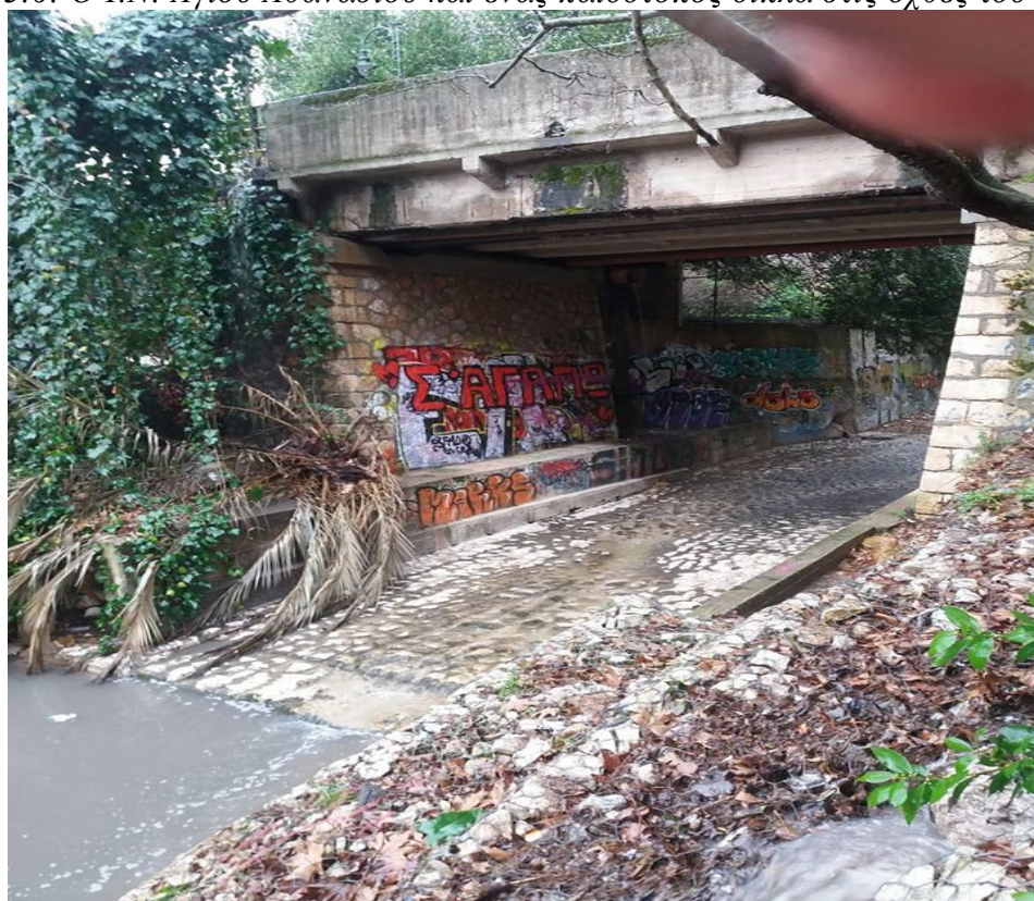
Εικόνα 3.7: Η γέφυρα στην Οδό Πολυδρόσου
