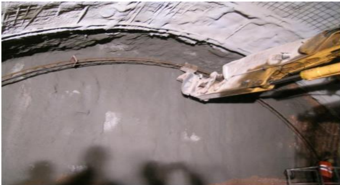
Εικόνα 1.6.2: Τοποθέτηση δικτυωτών πλαισίων στην σήραγγα Πλατάνου
