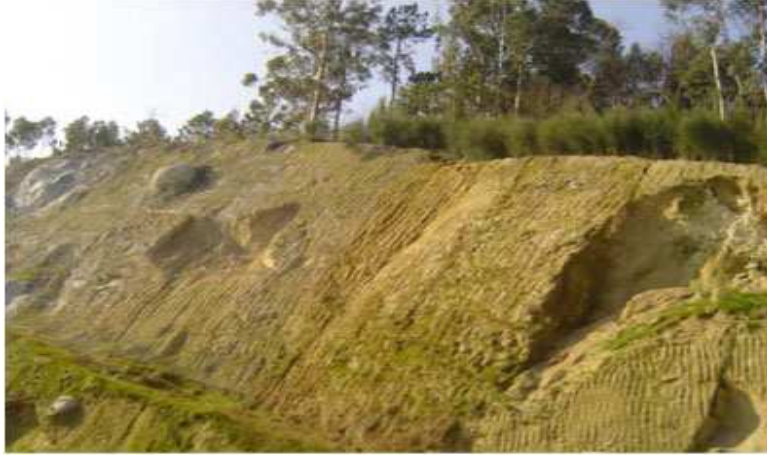
Σχήμα 20. Μεταβλητή φύση με όλες τις πιθανές καιρικές συνθήκες σε δρόμο με διεργημένο γρανίτη. (Critical review of Eurocode-7 regarding rock mass characterization, A.M. Ferrero, A.I. Sofianos, L.R. Alejano)
