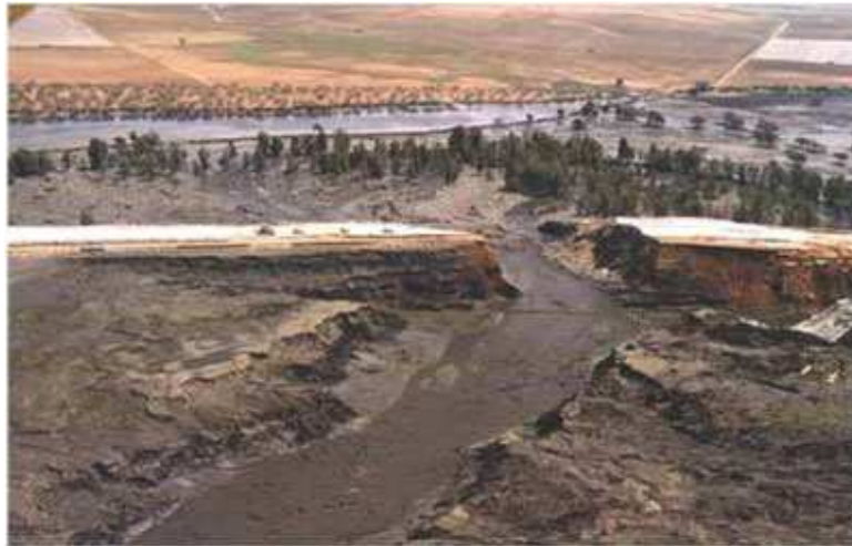
Σχήμα 16. Αστοχία του φράγματος του Aznalcóllar, κοντά στη Σεβίλλη (Ισπανία) στις 24 Απριλίου του 1998, όπου απορρίμματα ελευθερώθηκαν στον ποταμό Amargo. ( http://www.pensandoelterritorio.com .)
