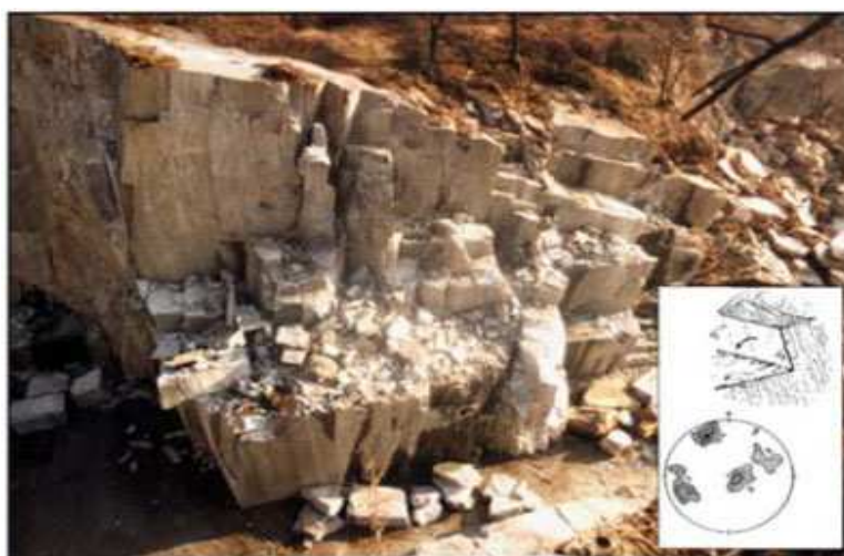
Σχήμα 19. Άποψη ενός λατομείου στην περιοχή των Άλπεων που δείχνει μια τυπική μορφή δομής που ενεργοποιούν τους μηχανισμούς αστοχίας για την ανατροπή και η στερεογραφική προβολή της περιοχής των πόλων της ασυνέχειας της βραχομάζας (δεξιά πλευρά). (Critical review of Eurocode-7 regarding rock mass characterization, A.M. Ferrero, A.I. Sofianos, L.R. Alejano)
