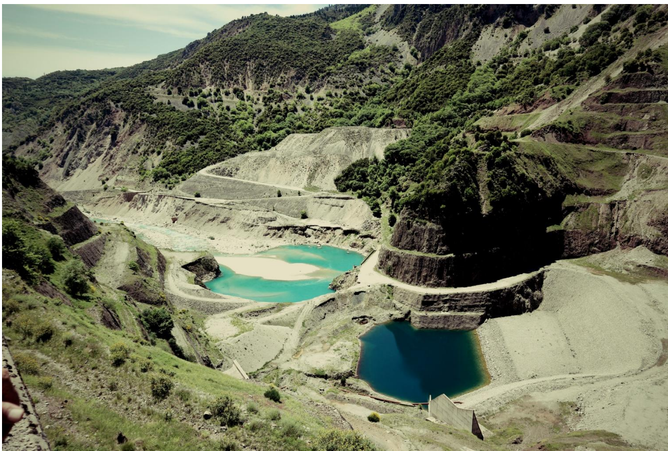
Εικόνα 9: Το υπο κατασκευή φράγμα Συκιάς
