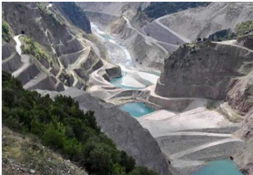
Εικόνα 15: Αρχικό στάδιο κατασκευής
