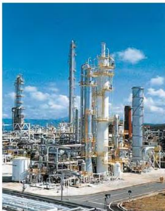
Σχήμα 7 : Εργοστάσιο δέσμευσης CO_2 μετά την καύση Μαλαισίας (χημική απορρόφηση), (Metz et al.,2005)
