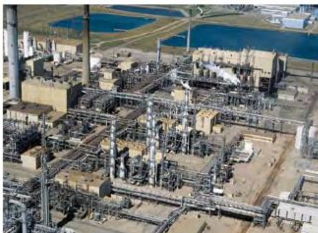
Σχήμα 4: Δέσμευση διοξειδίου του άνθρακα πριν την καύση σε εργοστάσιο αεριοποίησης άνθρακα ΗΠΑ (Metz et al., 2005)
