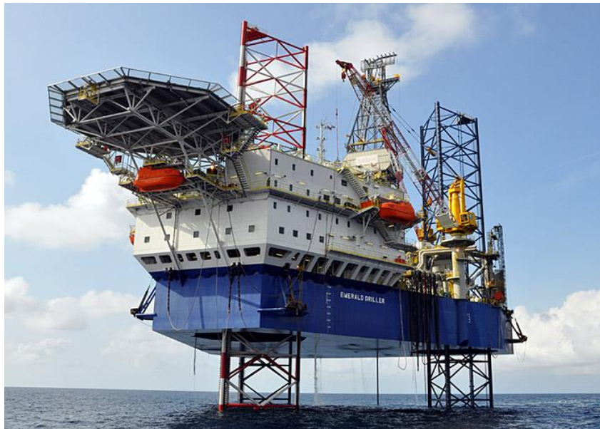
Εικόνα 0.2. Τύπου jackup εξέδρα [4].
