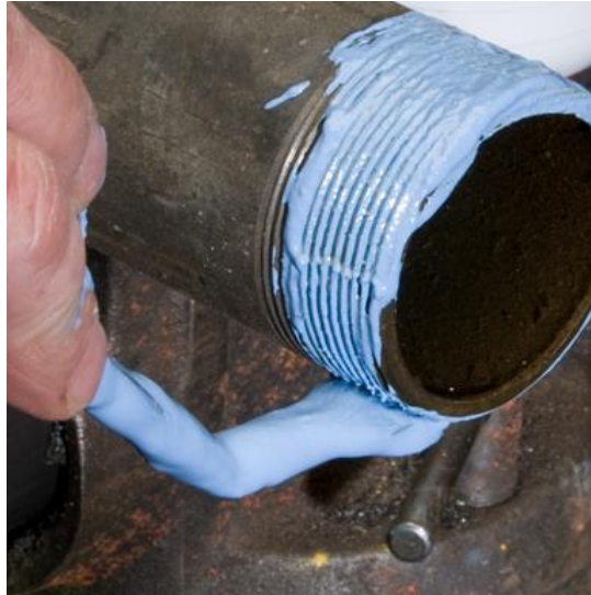
Σχήμα 2.9: Λιπαντικό νήμα για τη στεγάνωση της σύνδεσης (LA-CO Industries, n.d.)
