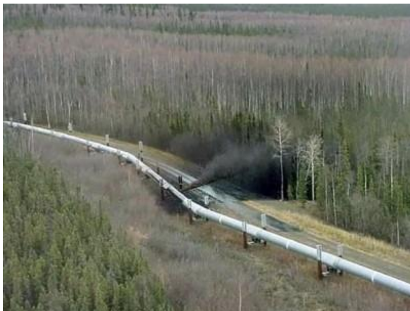
Εικόνα 11. Ατύχημα σε αγωγό πετρελαίου
