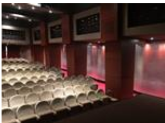
Εικόνα Z.9: Εσωτερική άποψη του θεάτρου «Κάππα» (κυματοειδής ανακλαστήρας πλευρικών παρειών και λεπτομέρεια πάχους)
