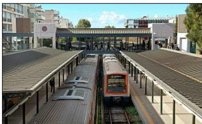
Εικόνα 4-6: Σταθμός ΗΣΑΠ Καλλιθέας Πηγή: https://el.wikipedia.org
