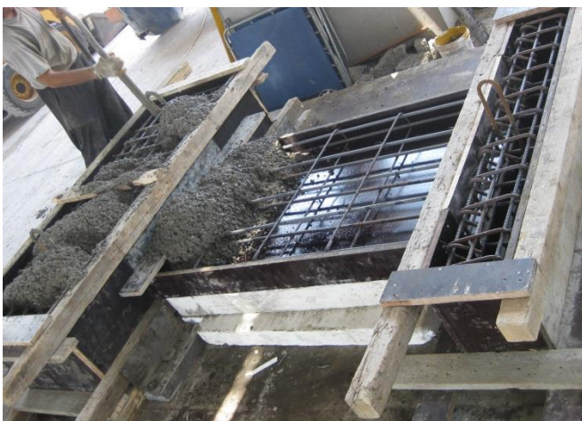
(α) Σκυροδέτηση τοιχίων (ΠΡΟΕΤ) σε οριζόντια θέση
