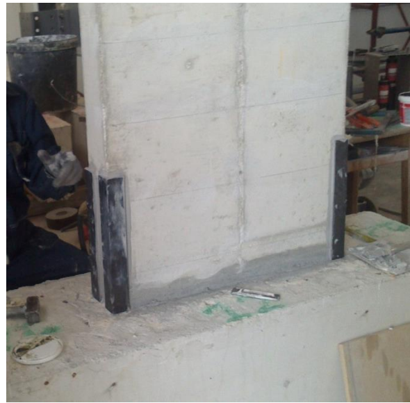
(δ) Τοποθέτηση μεταλλικών γωνιών
