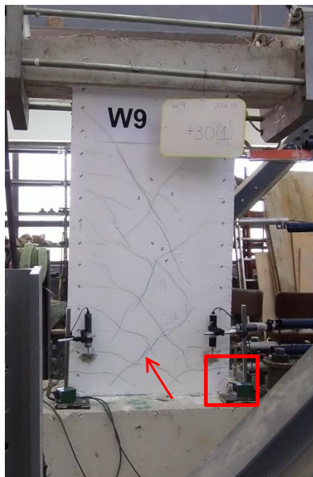
(α) Ρωγμές για μετακίνηση +30\text{mm}
