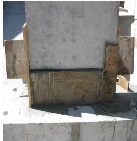
(β) Εφαρμογή επισκευαστικού κονιάματος
