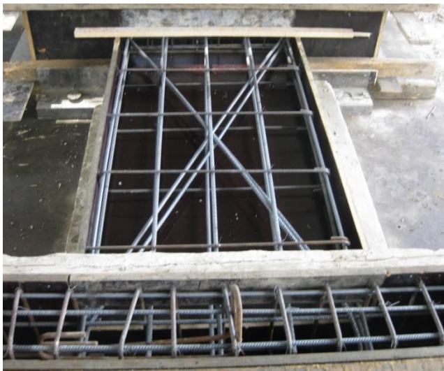
(α) Διαμόρφωση διαγώνιου οπλισμού τοιχίου W_3 (ΠΡΟΕΤ)
