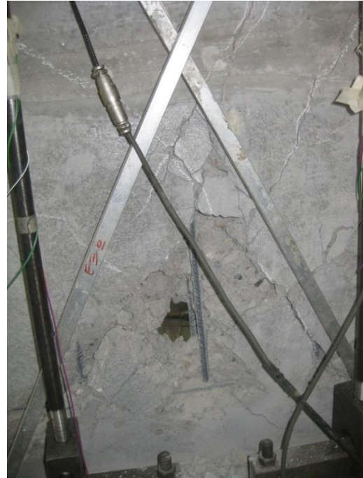
(β) Ρωγμές μετά το τέλος του πειράματος – Πίσω όψη
