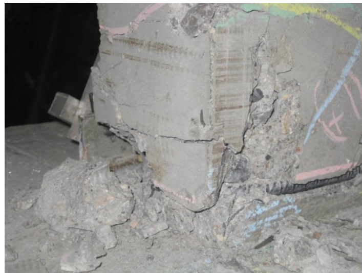
Σχήμα 4.6 Αποδιοργάνωση σκυροδέματος στην βάση του δοκιμίου W_1
