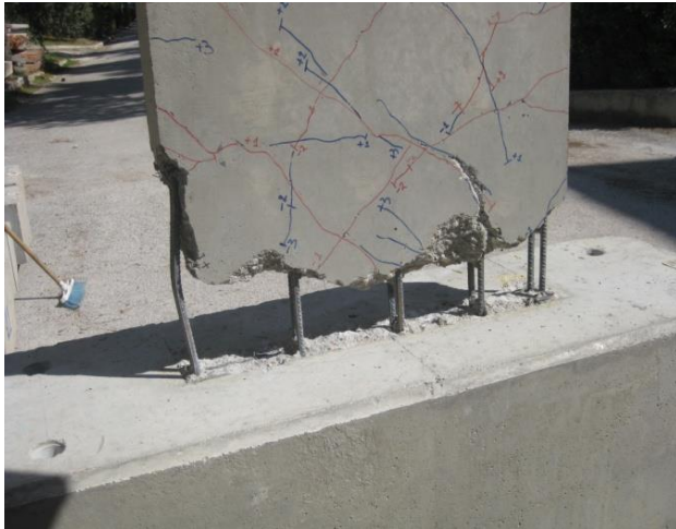
(α) Απομάκρυνση κατεστραμμένου σκυροδέματος
