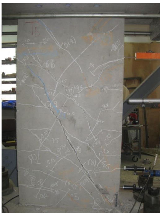
(α) Ρωγμές κατά τον 1 ο κύκλο των \pm 30\text{mm}
