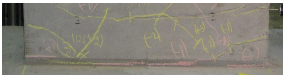
Σχήμα 4.4 Οριζόντια ρωγμή στην βάση κατά τον πρώτο κύκλο των \pm 20\text{mm} τοιχείου W_1
