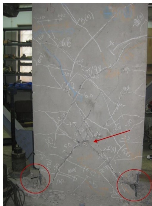
(β) Ρωγμές στον 3 ο κύκλο των \pm 30\text{mm}
