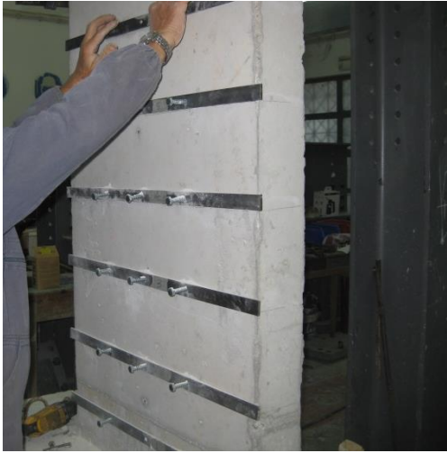
(α) Τοποθέτηση οριζόντιων λαμών
