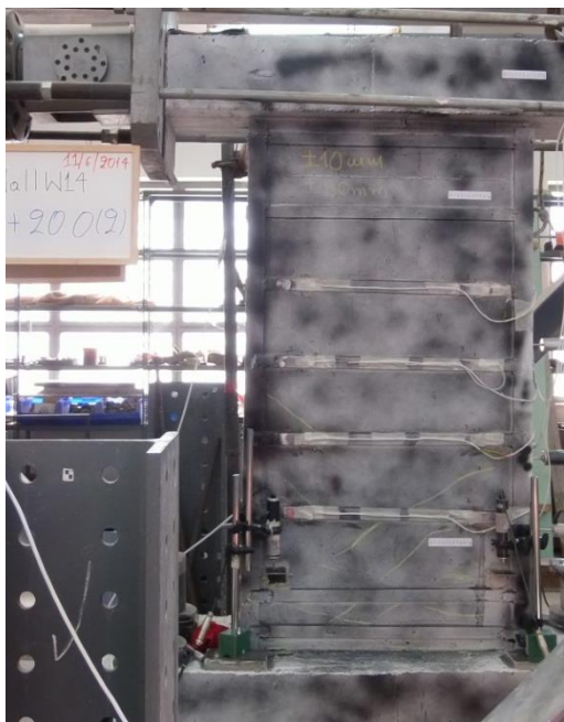
(α) Ρωγμές στον 2 ο κύκλο +20\text{mm}
