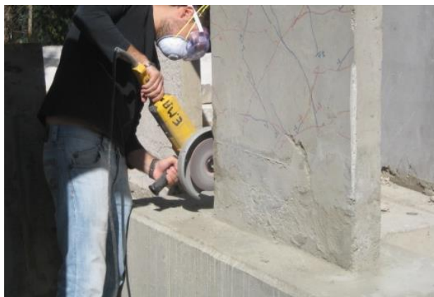
(γ) Λείανση επιφάνειας και καμπύλωση γωνιών
