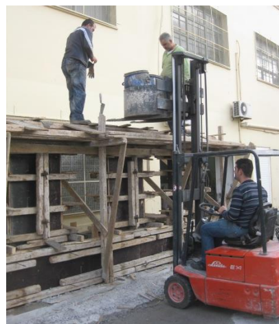
(β) Σκυροδέτηση τοιχίων (ΕΜΠ)
