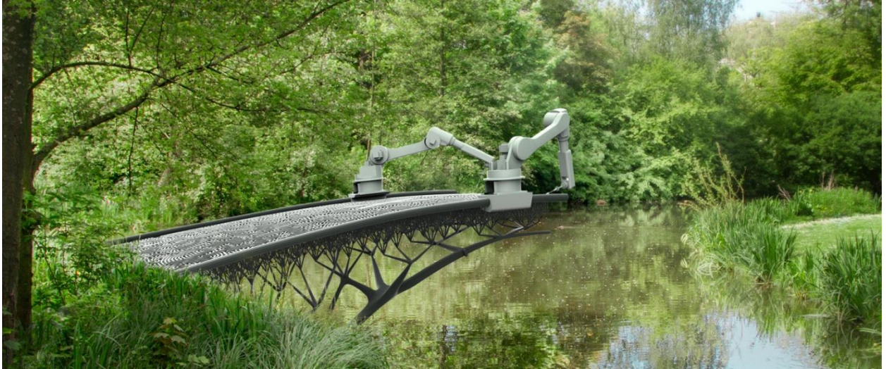
Εικόνα 1.9: Τριδιάστατα εκτυπωμένα γέφυρα από ατσάλι στο Άμστερνταμ 40
