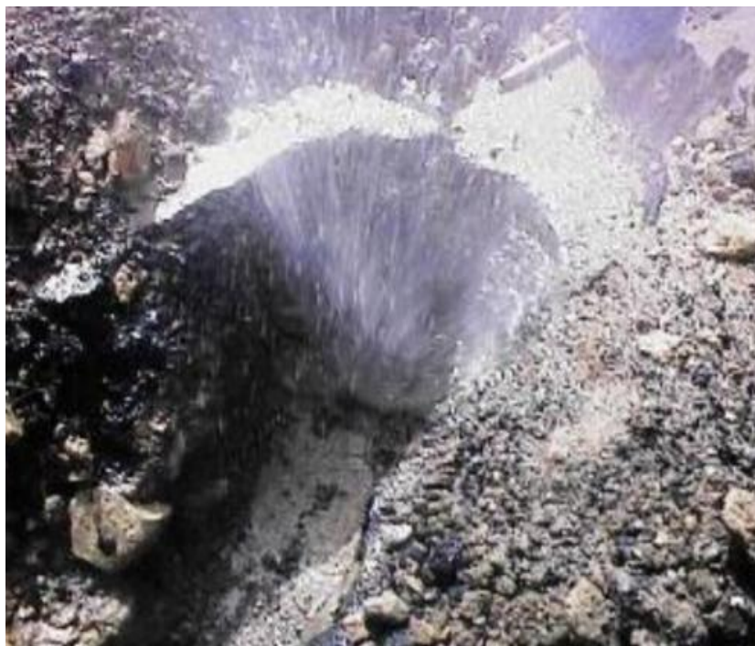
Σχήμα 4.4: Διαρροή σε κεντρικό αγωγό (Pilcher, 2002).
