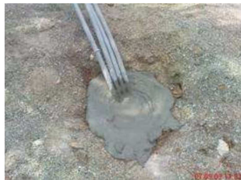
Εικόνα 4: Εισαγωγή ενέματος και πλήρωση κατακόρυφων γεωεναλλακτών
