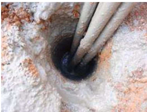
Εικόνα 4: Εισαγωγή ενέματος και πλήρωση κατακόρυφων γεωεναλλακτών
