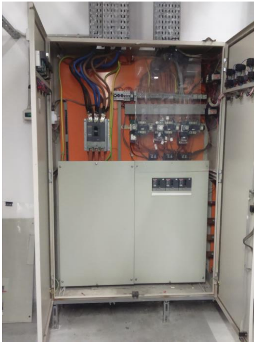
Εικόνα 3.7: Φωτογραφία του πίνακα ασφαλειών και της ασφάλειας που συνδέεται το σύστημα του ψυχοστασίου
