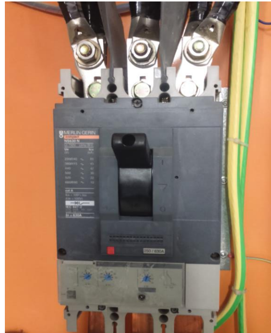
Εικόνα 3.7: Φωτογραφία του πίνακα ασφαλειών και της ασφάλειας που συνδέεται το σύστημα του ψυχοστασίου
