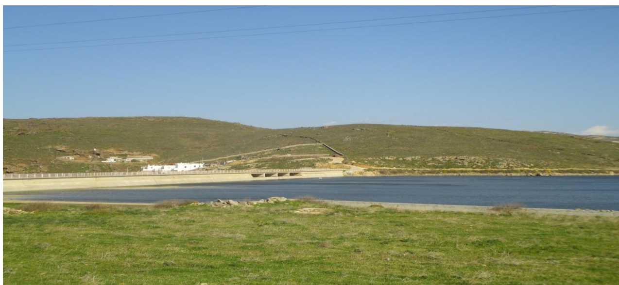
Εικόνα 4.2 Άποψη Φράγματος στη περιοχή Μαραθή
