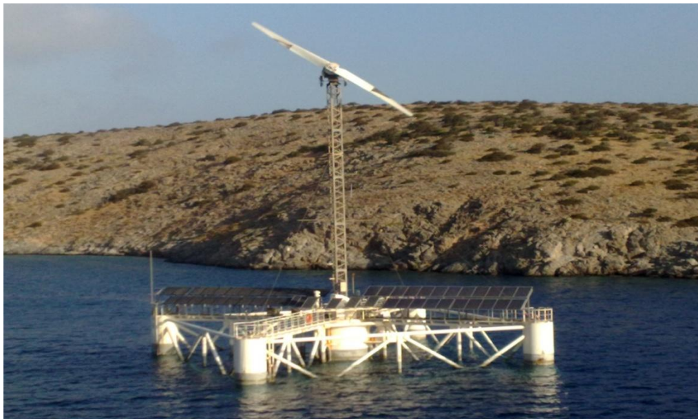
Εικόνα 2.2 Πλωτή μονάδα αφαλάτωσης εγκατεστημένη ανοιχτά του λιμένα της Ηρακλείας
