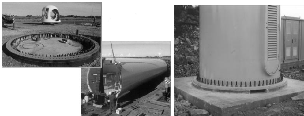
Εικόνα 3.12 Η βάση του πύργου είναι το σημείο με τις περισσότερες καταπονήσεις [17]
