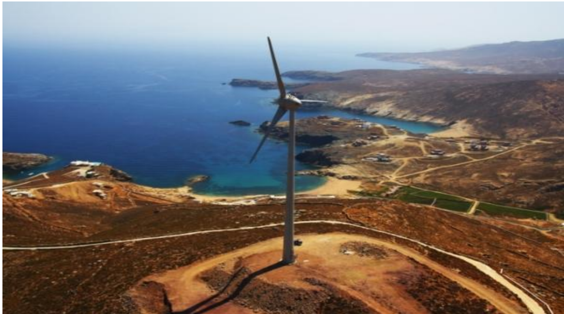
Εικόνα 4.6 Ανεμογεννήτρια Epercon E-44, 900kW, που λειτουργεί από το 2006 στη περιοχή Μερσίνη, ιδιοκτησίας της μονοπρόσωπης εταιρείας EVERWIND ΕΠΕ
