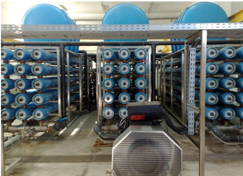
Εικόνα 5.4 Άποψη των 3 νέων μονάδων αφαλάτωσης αντίστροφης όσμωσης όπου διακρίνονται τα 15 δοχεία πίεσης ανά μονάδα αφαλάτωσης, τα δοχεία έκπλυσης ( Draw Back Tank ) και ο κινητήρας της αντλίας υψηλής πίεσης της μεσαίας μονάδας [1]
