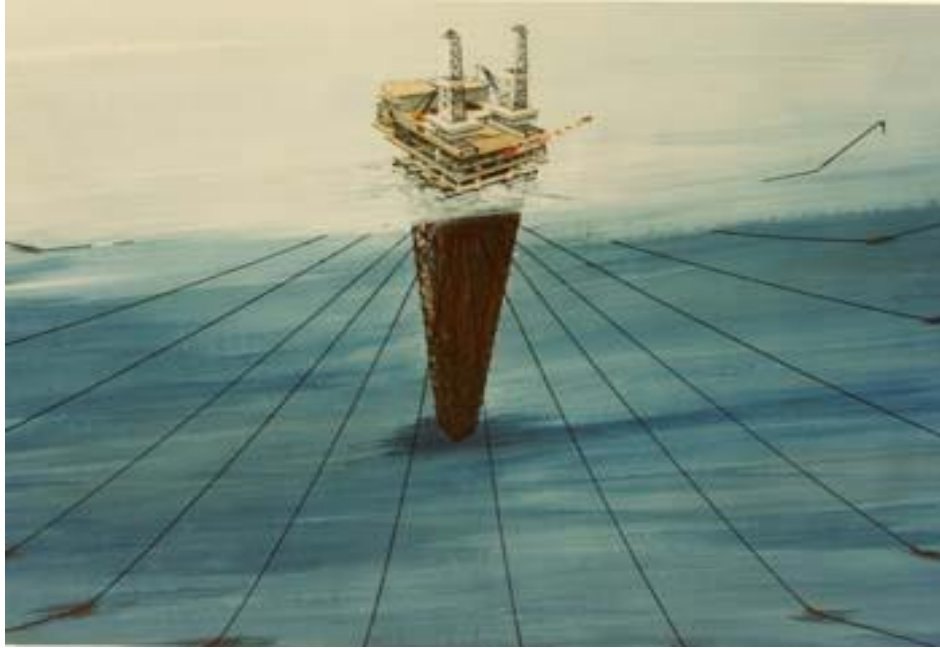
Σχήμα 16 Πύργος καλωδιωτού ιστού (Πηγή: www.smetak.com ).
