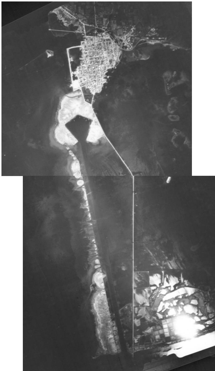
Εικ. 16. Διαμόρφωση του λιμανιού, η νησίδα Κλείσοβα και ο δρόμος προς την Τουρλίδα (Α/Φ 1937)
