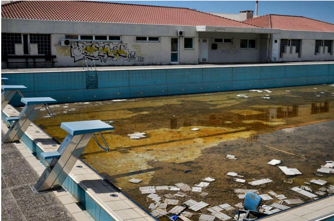
Εικόνα 16. Σημερινή εικόνα του κολυμβητηρίου του Ολυμπιακού Χωριού το οποίο δε λειτούργησε ποτέ μετά τους αγώνες (Πηγή: << http://protinews.blogspot.gr/2014/08/blog-post_836.html >>, τελευταία ανάκτηση 22/6/2017)
