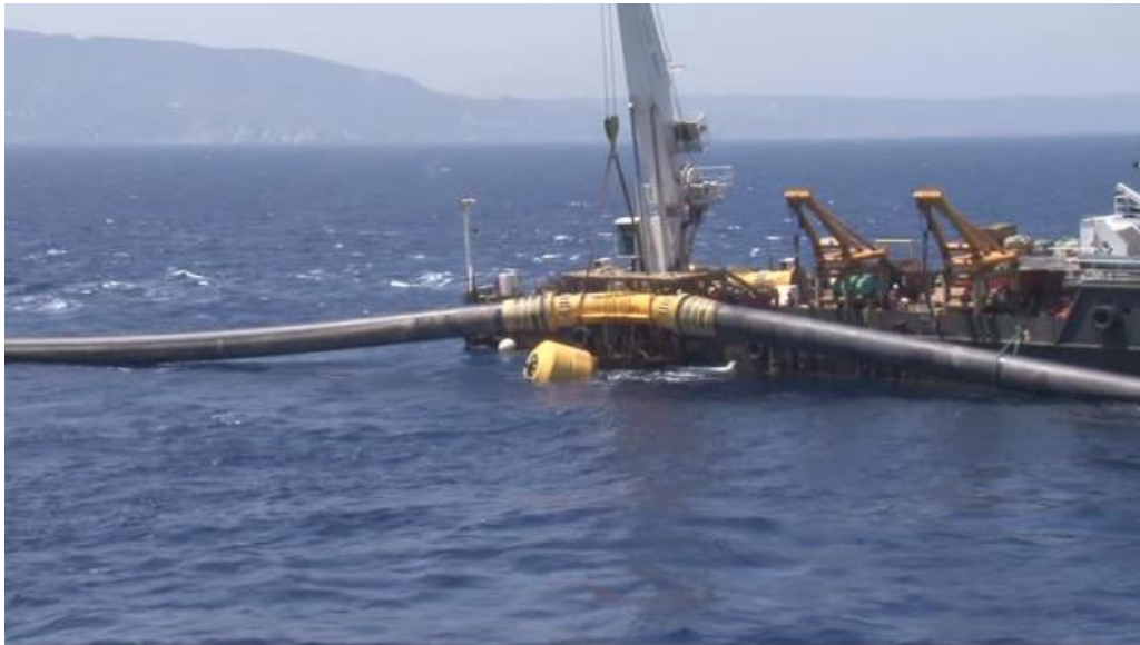
Εικόνα 2.3: Αγωγός μεταφοράς νερού από την Τουρκία στην Κατεχόμενη Κύπρο
