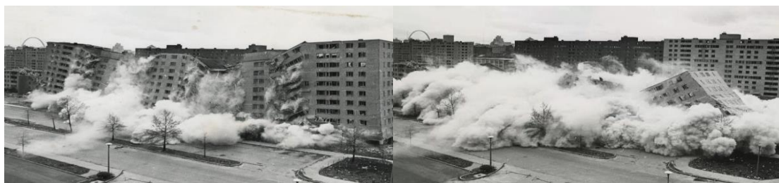
Εικόνα 2.1: Κατεδάφιση Pruitt Igoe, οικιστικού χώρου για άτομα χαμηλού εισοδήματος στο Σαιντ Λουίς, σχεδιασμένο από τον αρχιτέκτονα Minoru Yamasaki. Η κατεδάφιση του συμβολίζει τη μετάβαση από τον Μοντερνισμό στον Μεταμοντερνισμό (πηγή: http://numerocinqmagazine.com )
