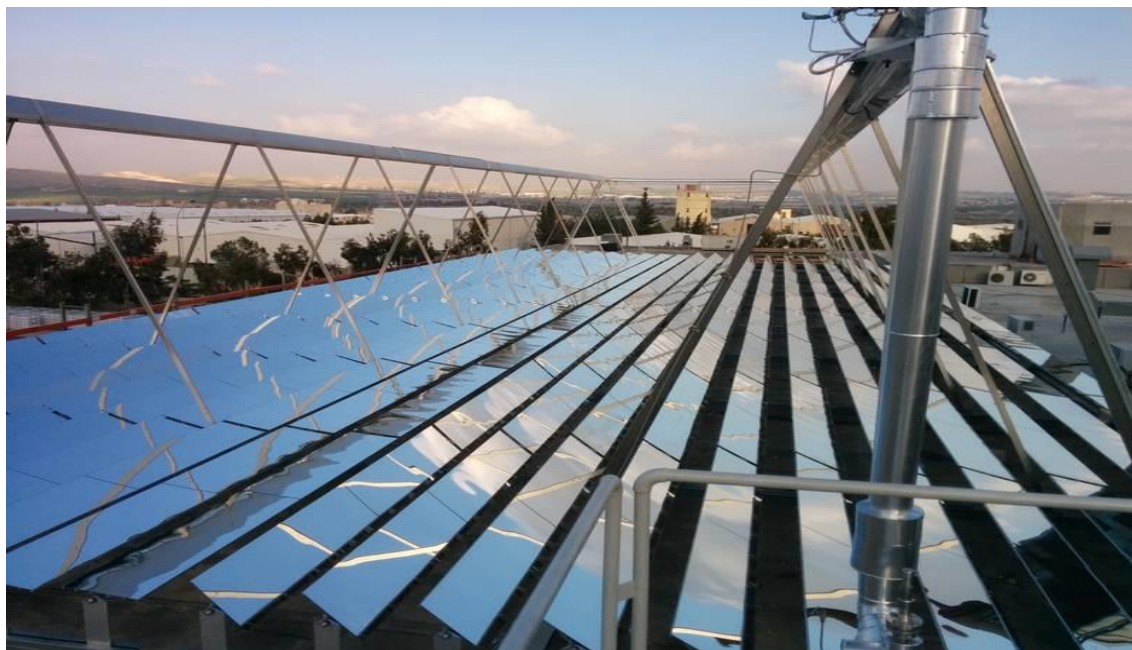
Εικόνα 2.11 Γραμμικός Συλλέκτης Fresnel [27]
