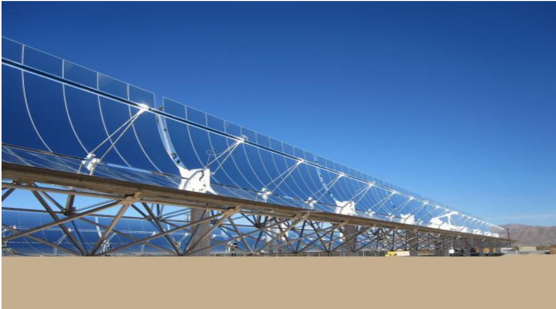
Εικόνα 2.10 Συλλέκτης τύπου PTC [25]
