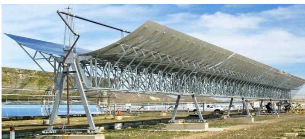
Εικόνα 3.2 Συλλέκτης EuroTrough [34]
