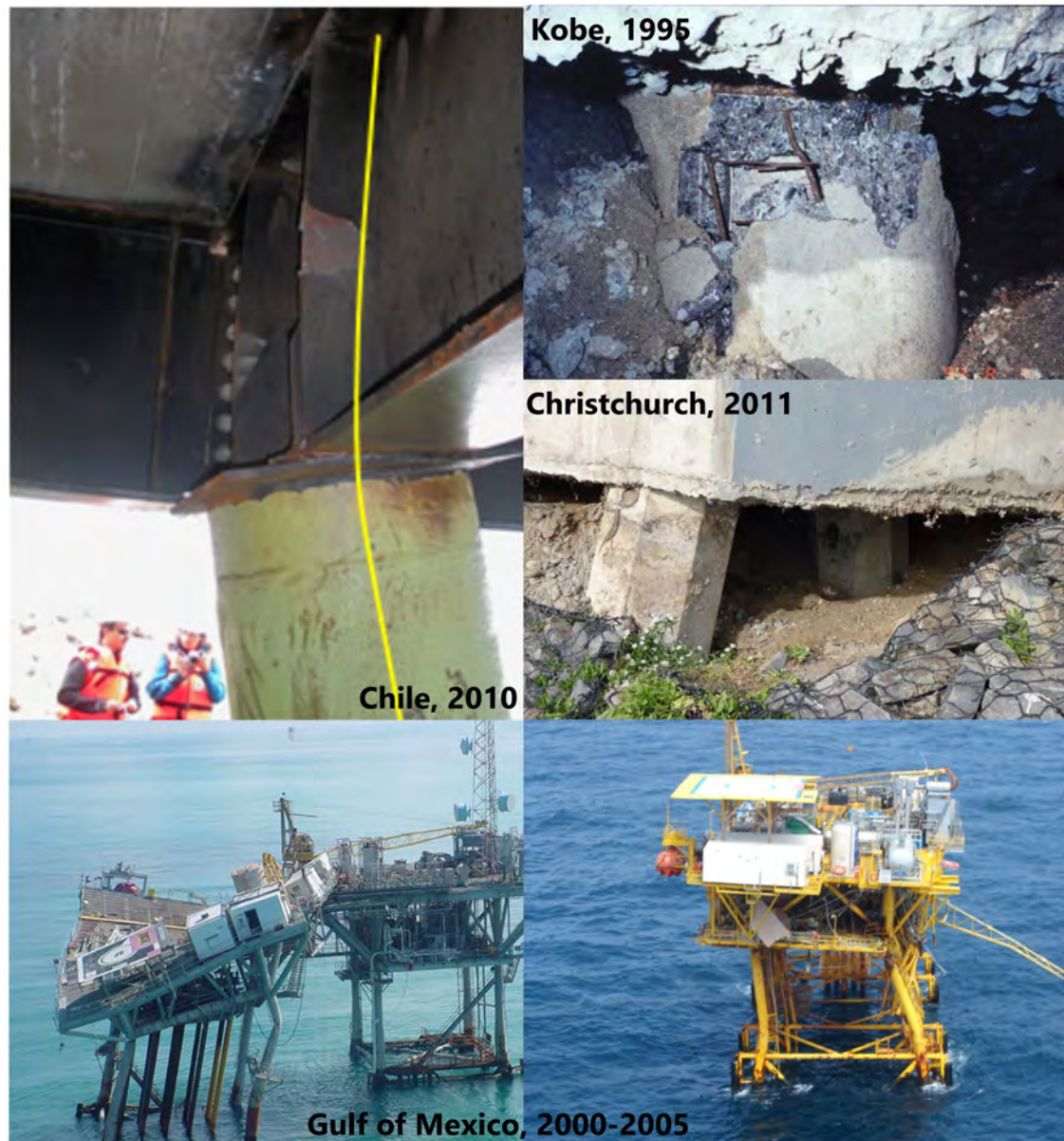
Σχήμα 1: Αστοχίες πασσάλων υπό εγκάρσια φόρτιση.
