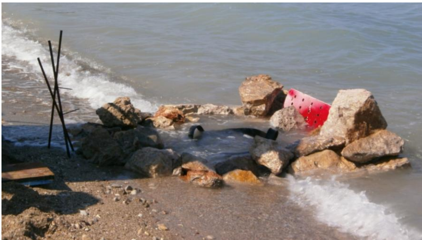
Εικόνες 3.2, 3.3, 3.4. Εργασίες για τη διάνοιξη και σταθεροποίηση πηγαδιού για την τοποθέτηση της αντλίας
