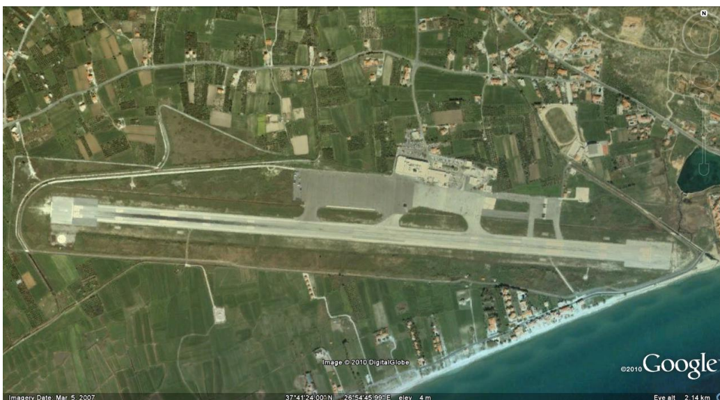
Εικόνα 4.10: Αεροδρόμιο Σάμου «Αρίσταρχος της Σάμου» (αεροφωτογραφία Google)
