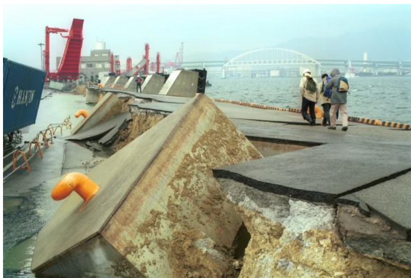
Εικόνα 2.4: Περιπτώσεις αστοχίας λόγω ρευστοποίησης κατά το σεισμό του Kobe της Ιαπωνίας (1995)
