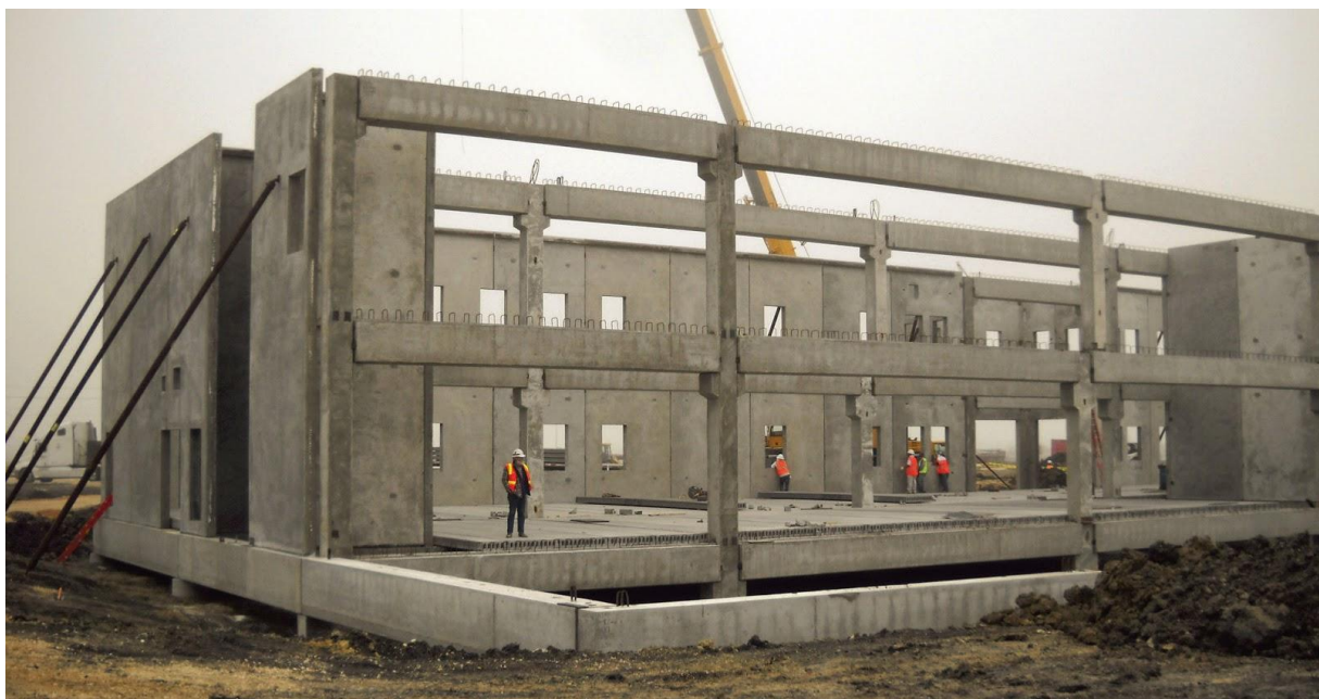
Εικόνα 14: Περίπτωση κτιρίου εξολοκλήρου κατασκευασμένου από προκατασκευασμένα στοιχεία οπλισμένου σκυροδέματος.
