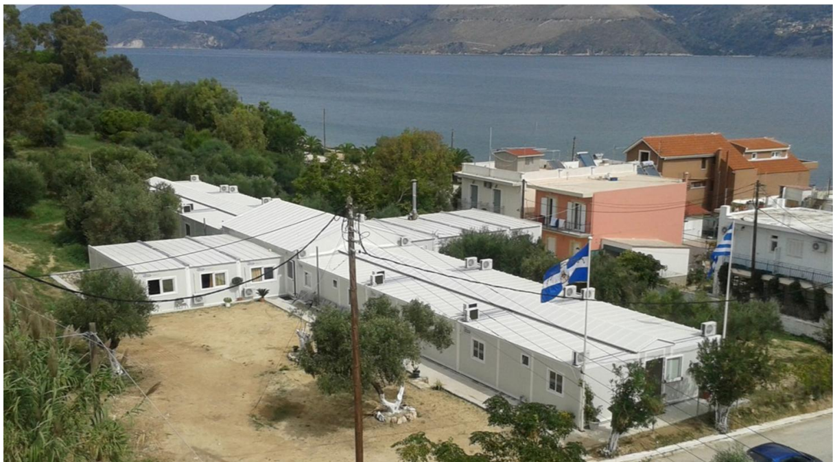
Εικόνα 52: Προκατασκευασμένη μονάδα φροντίδας ηλικιωμένων στο Ληξούρι Κεφαλονιάς μετά το σεισμό του 2014.
