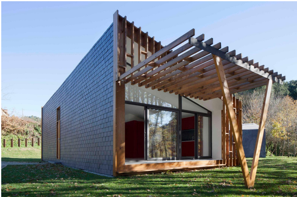
Εικόνα 6: Gomos Modular Home, Πορτογαλία, συναρμολόγηση σε 3 ημέρες.
