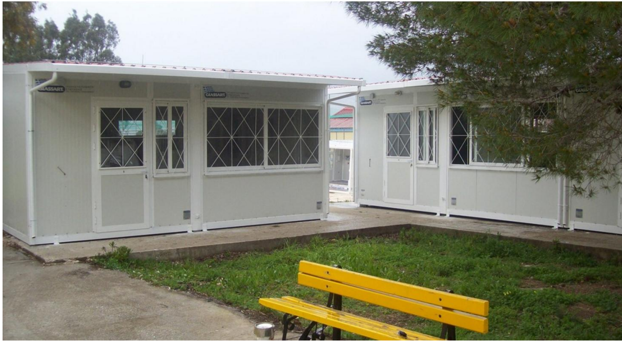
Εικόνα 53: Προκατασκευασμένο συγκρότημα σχολικών αιθουσών στο Ληξούρι Κεφαλονιάς μετά το σεισμό του 2014.
