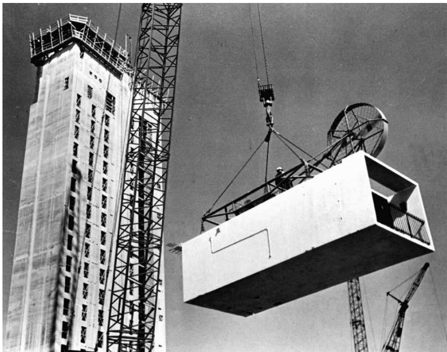
Εικόνα 40: Ανύψωση και τοποθέτηση μιας έτοιμης μονάδας προκατασκευασμένου δωματίου στο Hilton Palacio del Rio Hotel.
