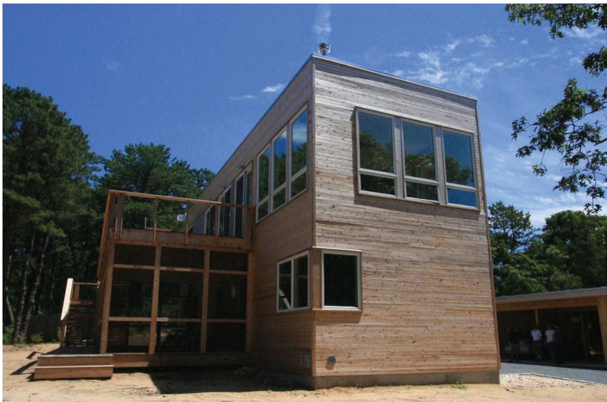
Εικόνα 5: Πλήρης προκατασκευασμένη ξύλινη κατοικία.
