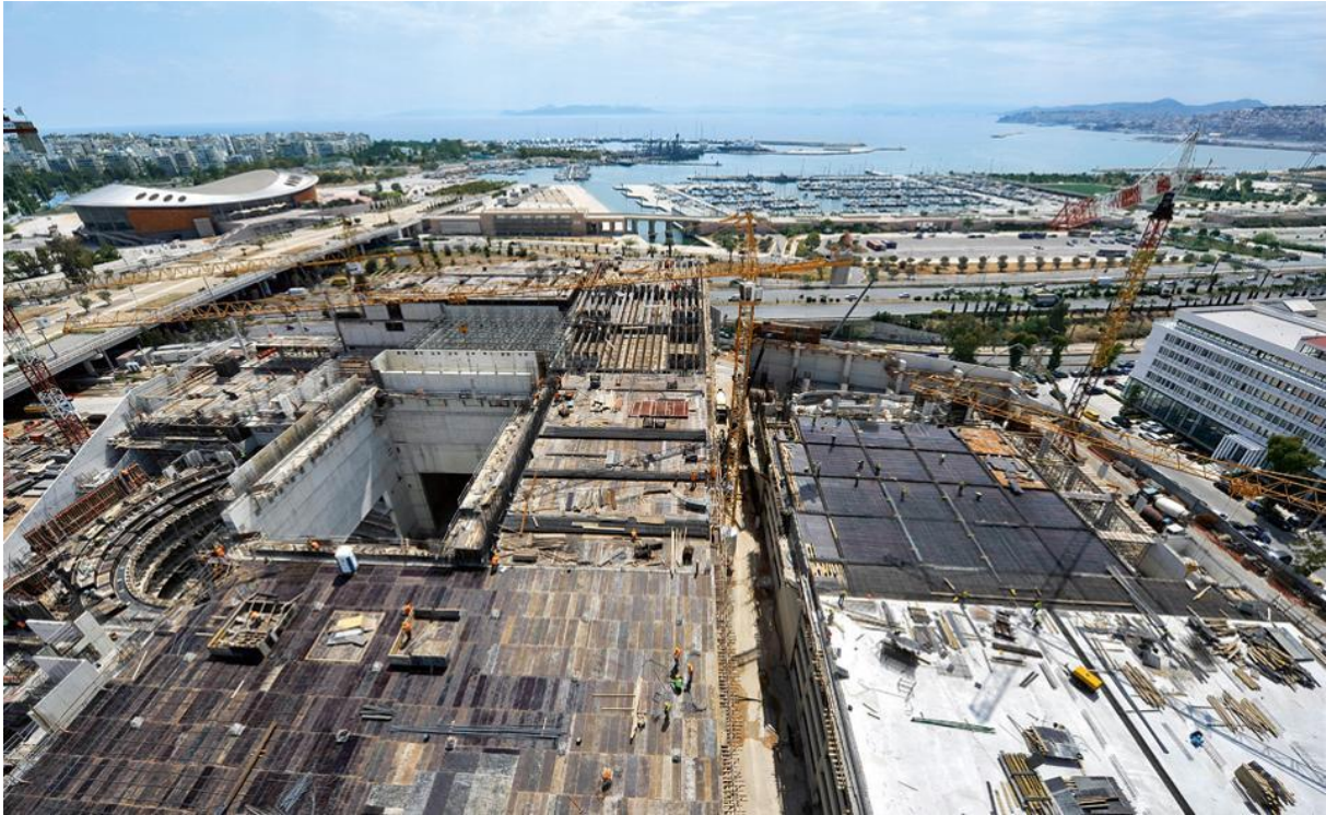
Εικόνα 1: Το εργοτάξιο του Κέντρου Πολιτισμού Ίδρυμα Σταύρος Νιάρχος (ΚΠΙΣΝ)
