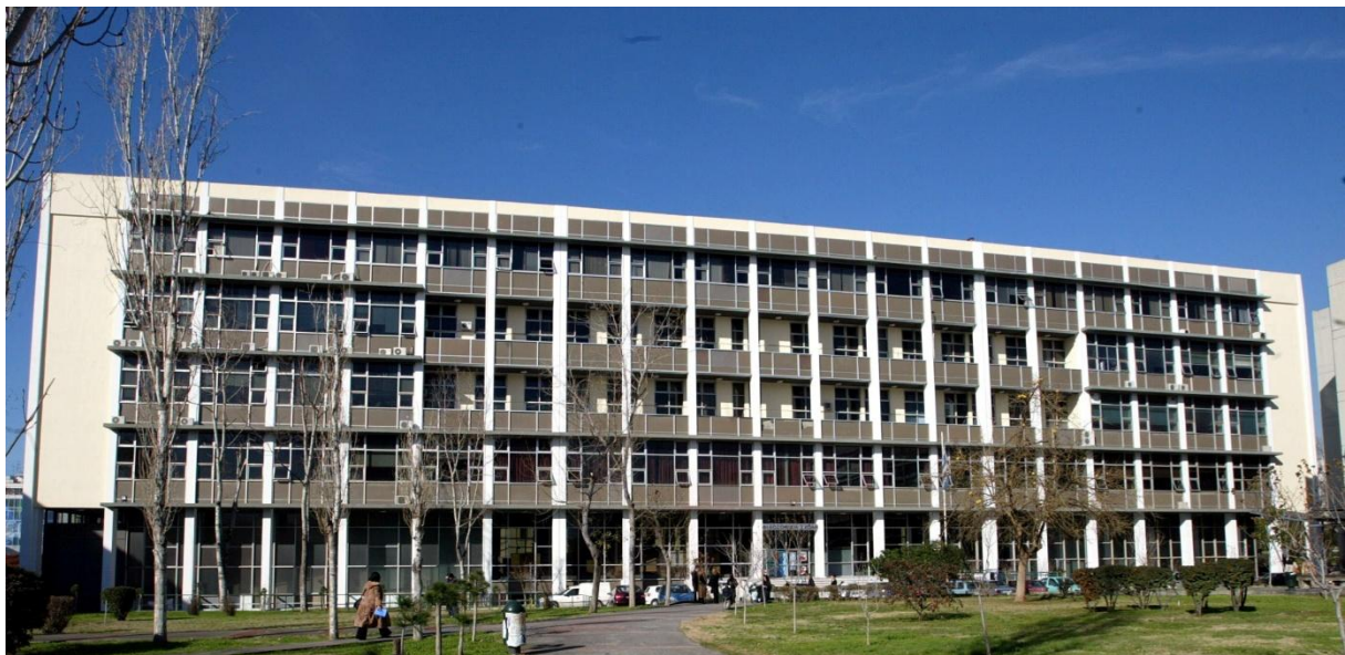
Εικόνα 2: Δομικός κάρναβος σε κτήριο του Αριστοτελείου Πανεπιστημίου (ΑΠΘ)
