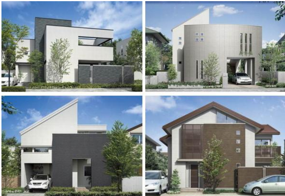
Εικόνα 42: «Στυλιστικές» προκατασκευασμένες κατοικίες της Toyota.
