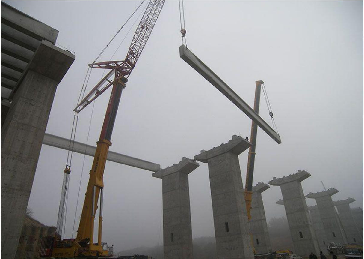
Εικόνα 47: Τοποθέτηση προκατασκευασμένης δοκού σε γέφυρα της Εγνατίας Οδού.
