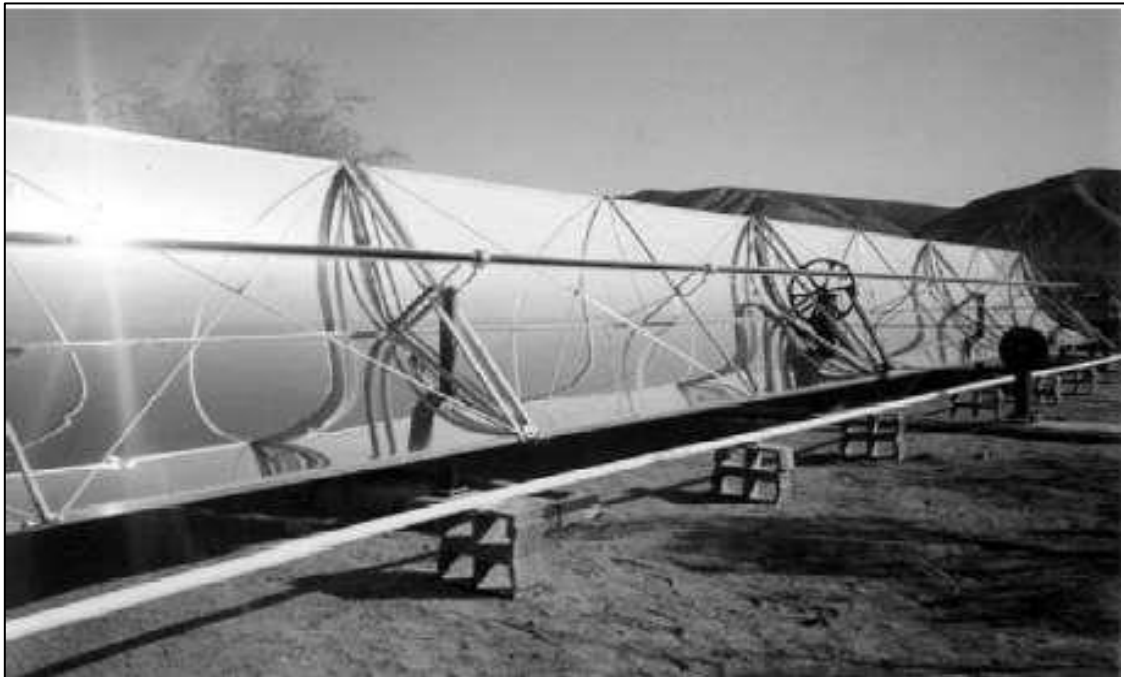
Εικόνα 1.2.5 Βιομηχανική εφαρμογή παραβολικού συλλέκτη (PTC)
