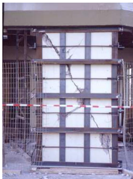
Εικόνα 63. Περίσφιγξη υποστυλώματος με σπειροειδή οπλισμό (αριστερά) και επέμβαση με μεταλλικό κλωβό για προσωρινή ανάληψη κατακόρυφων φορτίων (δεξιά)
