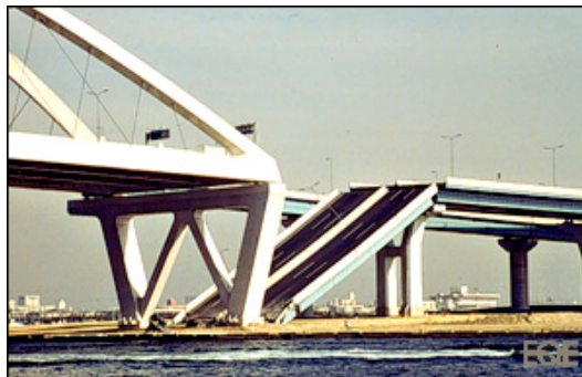
Figure 1: Η γέφυρα Nishinomiya-ko, πτώση ανοίγματος, Kobe 1995
