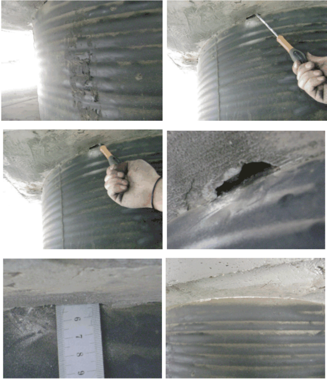
Figure 2 : Αστοχία βουλκανισμού και διάκενα
