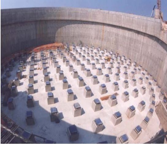
Figure 9: Δεξαμενή αποθήκευσης υγροποιημένου φυσικού αερίου
