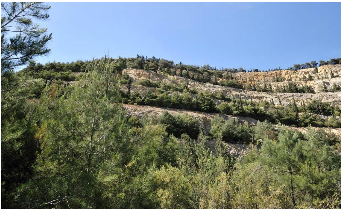
Εικόνα 6.2: Αποκατάσταση εξορυκτικού έργου στην περιοχή της Αγριάς Βόλου (ΣΜΕ)
