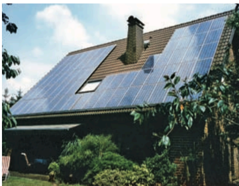
Εικόνα 4.8 Φωτοβολταϊκά στη στέγη (πηγή: Πολυτεχνείο Κρήτης, 2008)
