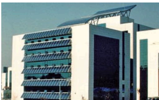
Εικόνα 4.10 Χρήση φωτοβολταϊκών ως σκίαστρα (πηγή: Πολυτεχνείο Κρήτης, 2008)
