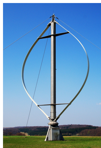
Εικόνα 4.19 αιολική μηχανή κατακόρυφου άξονα (πηγή: zeroenergybuildings.org )
