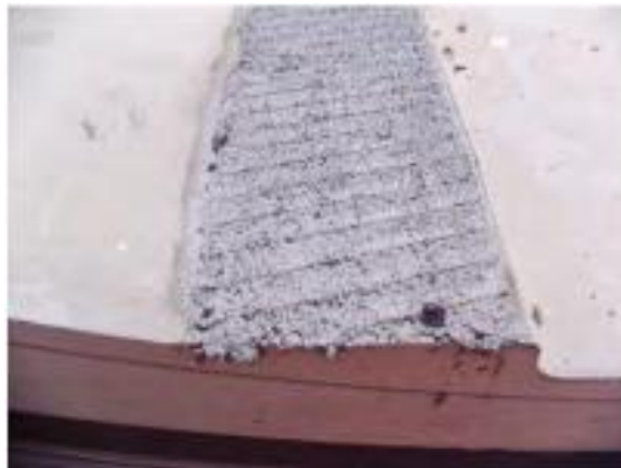
Εικόνα 14: Πλήρωση των νευρώσεων (WOLFGANG GUTTER, 2016)
