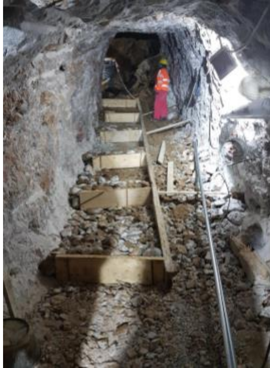
Εικόνα 27: Βοηθητική σήραγγα (JAEGER-BAU, 2016)
