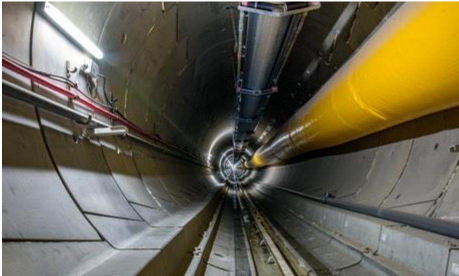
Εικόνα 7: Η σήραγγα του Αποσελέμη (JAEGGER-BAU, 2016)
