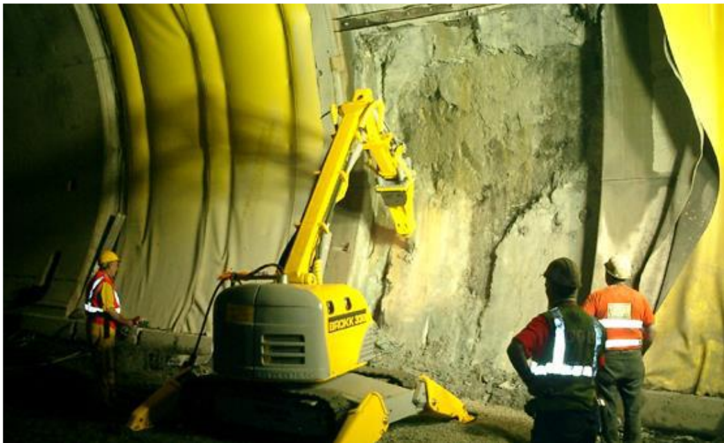
Εικόνα 26: Διάνοιξη βοηθητικής σήραγγας (INTRAKAT, 2016)
