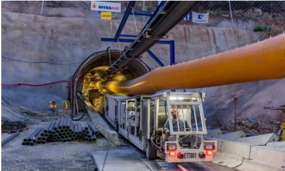
Εικόνα 16: Συνεχές Σύστημα Μεταφοράς (CCS) (JAEGER-BAU, 2016)
