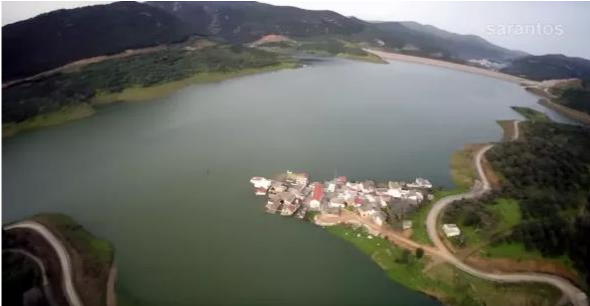
Εικόνα 4: Φράγμα Αποσελέμη (ΦΟΥΝΤΟΥΛΑΚΗ, 2015)
