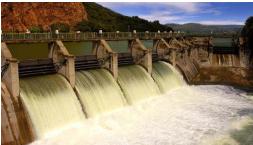
Εικόνα 1.3: Φωτογραφία υδροηλεκτρικού σταθμού Λάδωνα ( energypress.gr )
