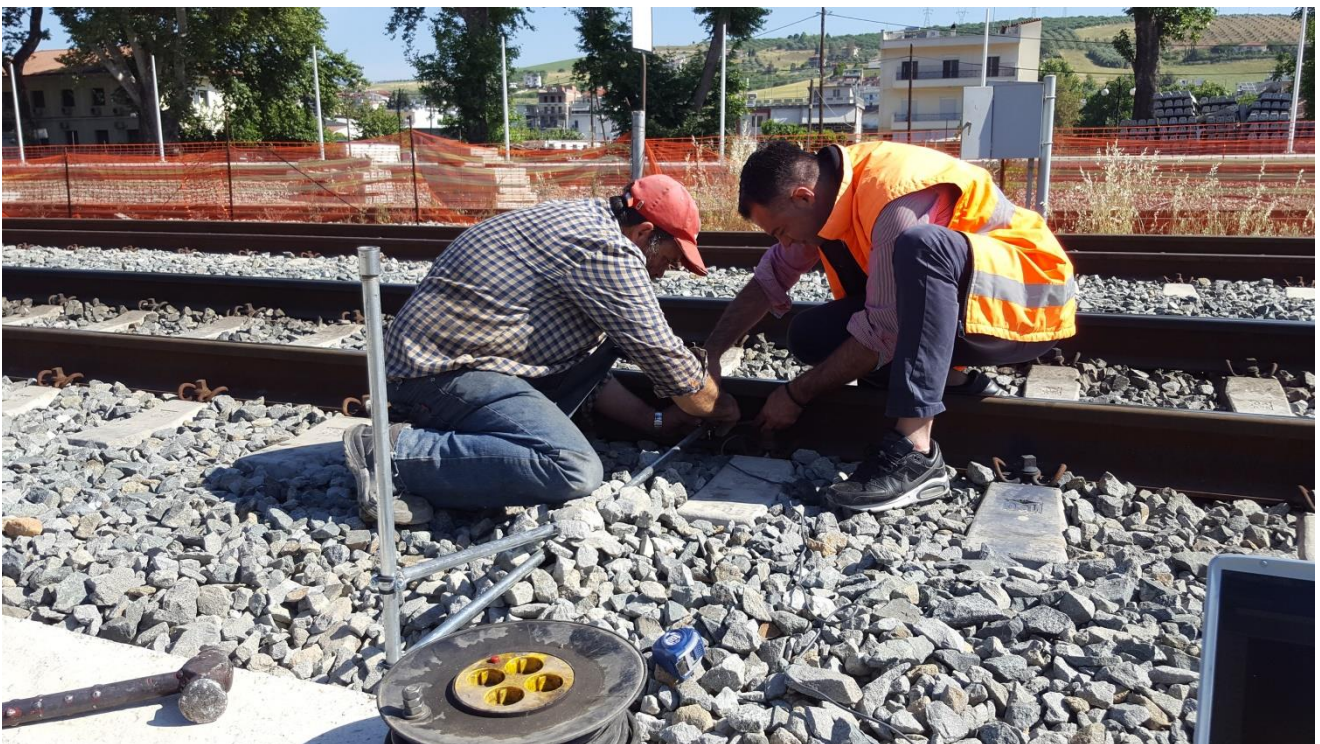
Εικόνα 4.4: Τοποθέτηση μηχανομετρητή
