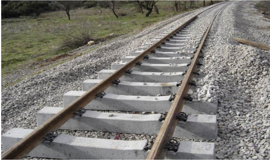
Εικόνα 2.12: Ολόσωμοι στρωτήρες από σκυρόδεμα
