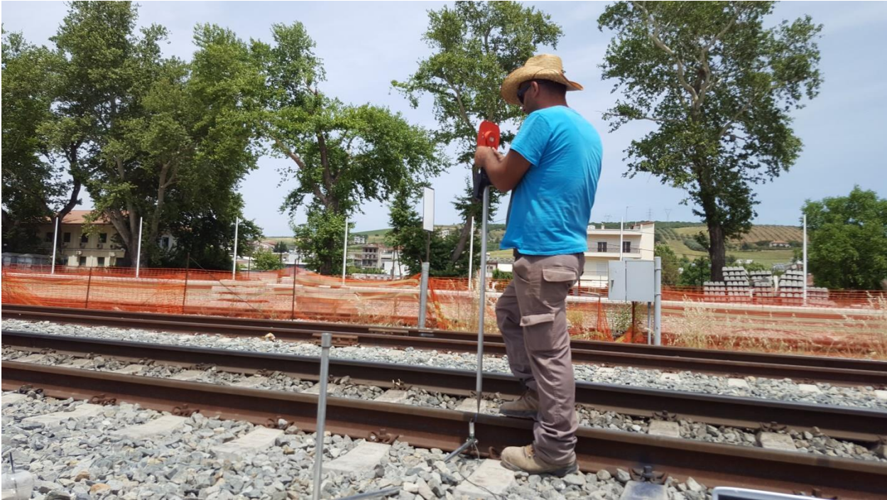
Εικόνα 4.1: Μέλος τοπογραφικού συνεργείου για την εύρεση της χιλιομετρικής θέσης της διατομής των μετρήσεων
