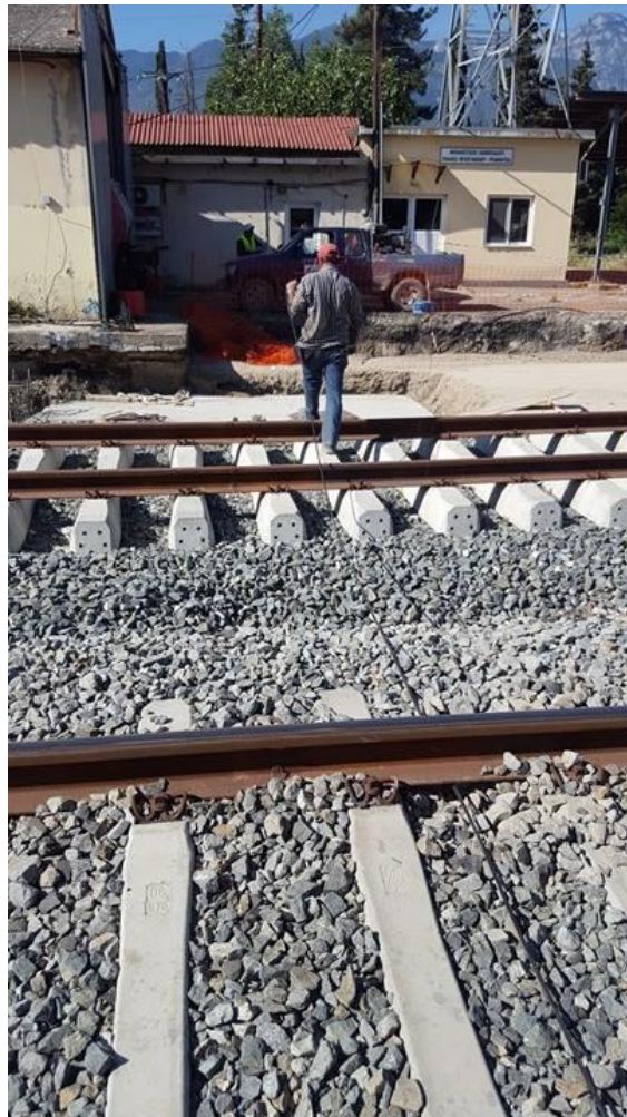
Εικόνα 4.10: Διαδικασία απόκτησης πρόσβασης στην πηγή ηλεκτρικού ρεύματος
