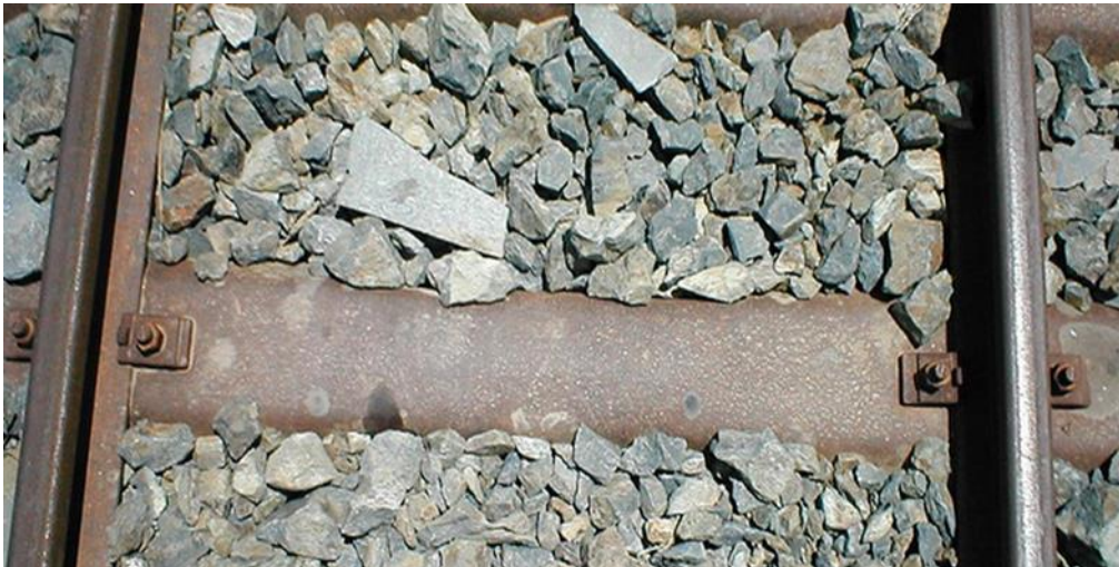
Εικόνα 2.14: Μεταλλικός στρωτήρας
