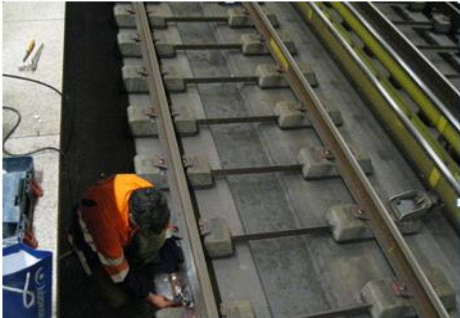
Εικόνα 2.13 : Διμερείς στρωτήρες από σκυρόδεμα στο Αττικό Μετρό
