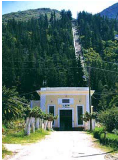
Εικόνα 2: Υ/Η σταθμός Γλαύκου
