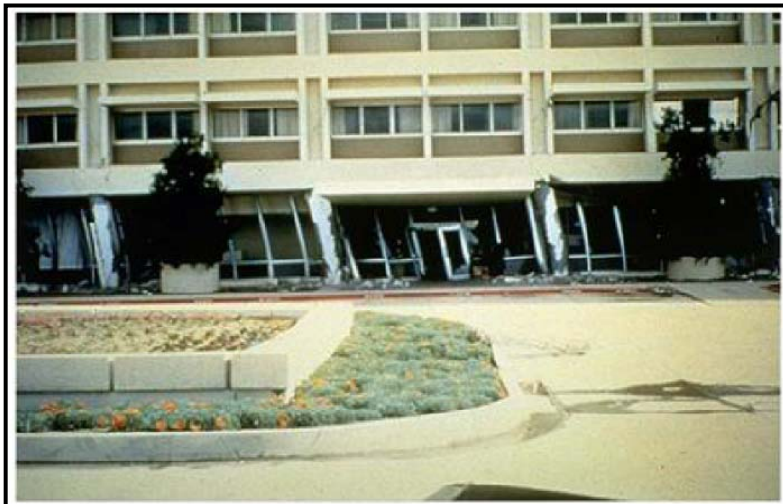
Εικόνα 3.12: Φαινόμενο του “μαλακού” ορόφου
